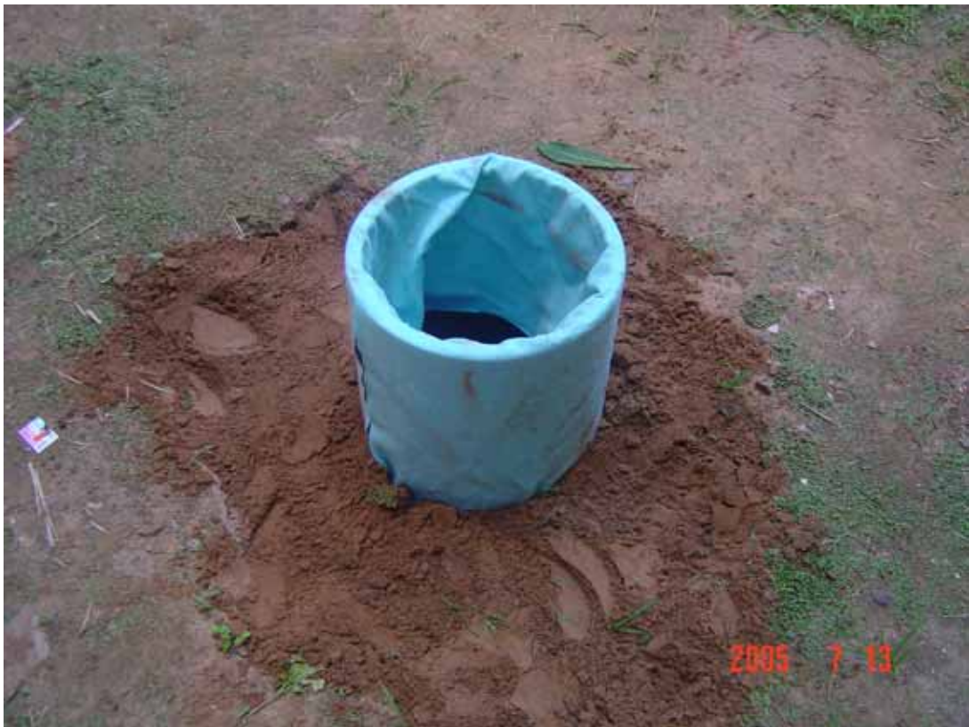
圖 5-17 試驗滲透陰井鋪設完成圖
