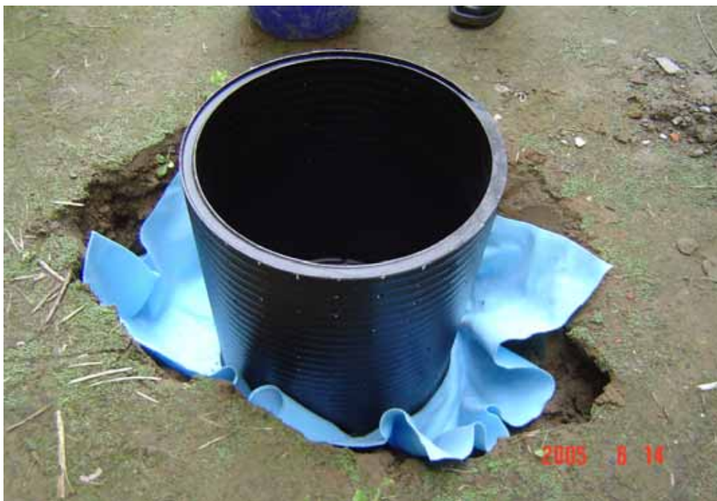
圖 5-16 試驗滲透陰井鋪設概況 (4)
