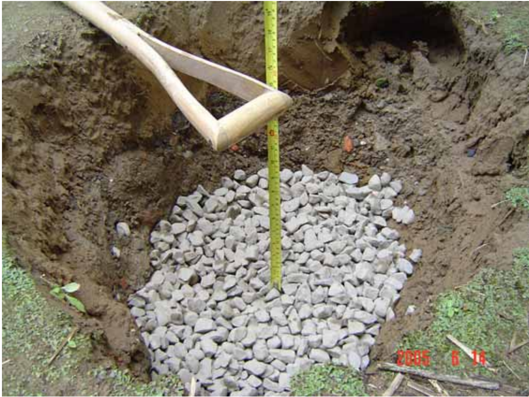
圖 5-13 試驗滲透陰井鋪設概況 (1)
