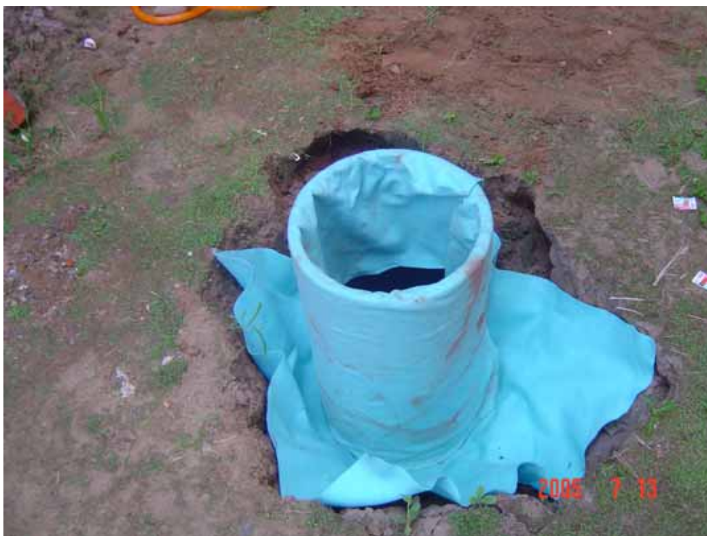
圖 5-16 試驗滲透陰井鋪設概況 (4)
