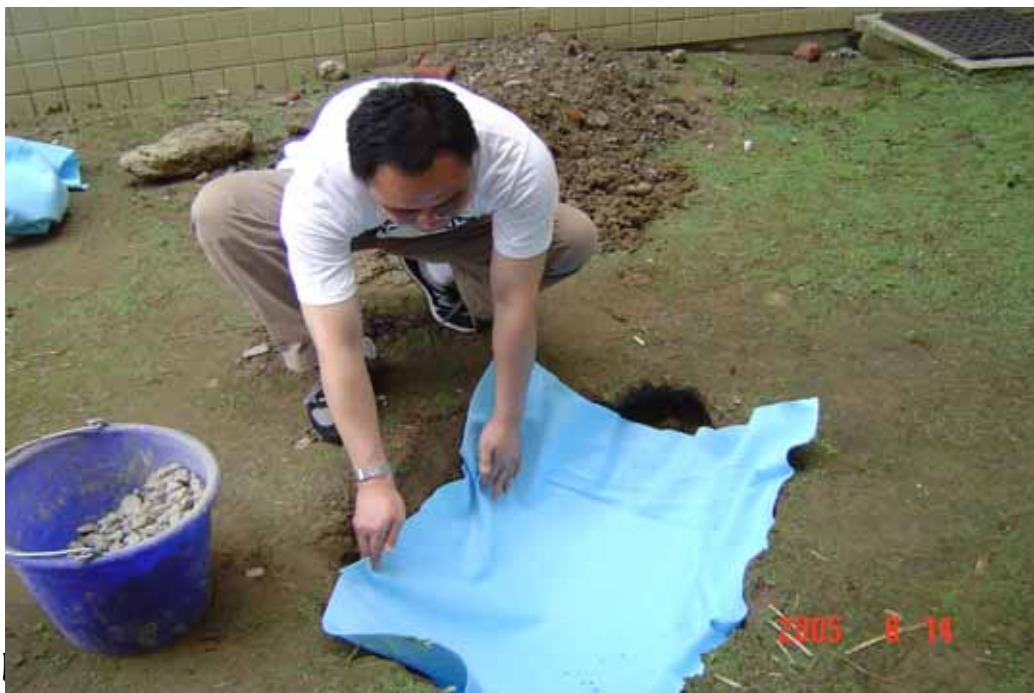
圖 5-14 試驗滲透陰井鋪設概況 (2)
