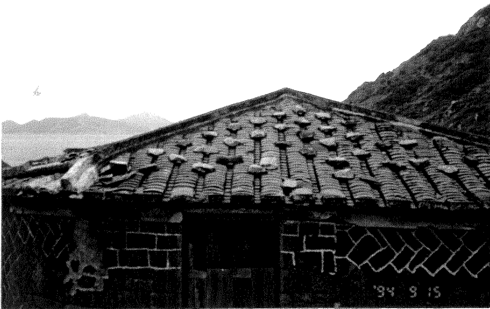
圖3-4 瓦片以石塊牢固抵擋風力
