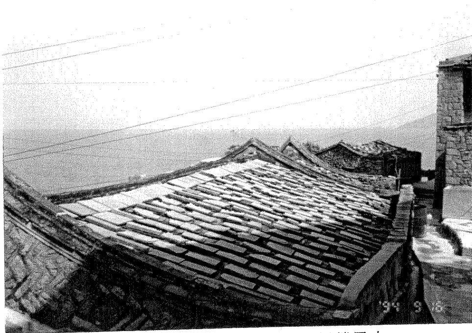
圖3-6 瓦片以混凝土板塊牢固抵擋風力
