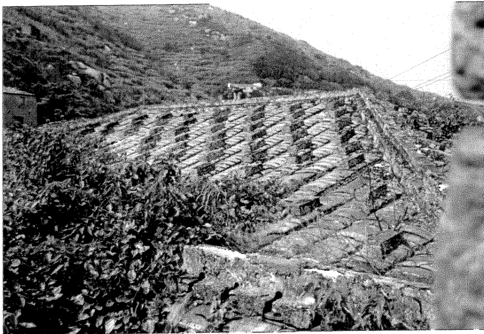
圖3-5 瓦片以紅磚牢固抵擋風力
