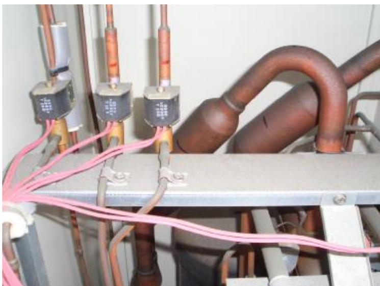
(七)為因應冷媒壓縮機長時運轉於不同負載率之下，產生之系統冷媒流量大幅變動之情況，而導致液壓縮，必須經由貯液器加以吸收，如圖 3-16。
