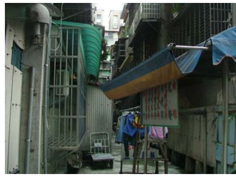
照片 4-18 社區違建情形
