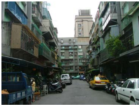
照片 4-17 社區違建情形
