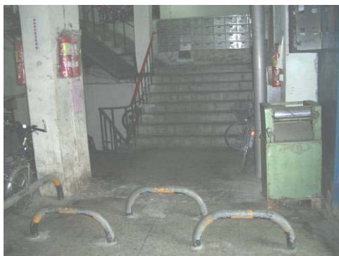
照片 4-7 3 號建物出入口現況
