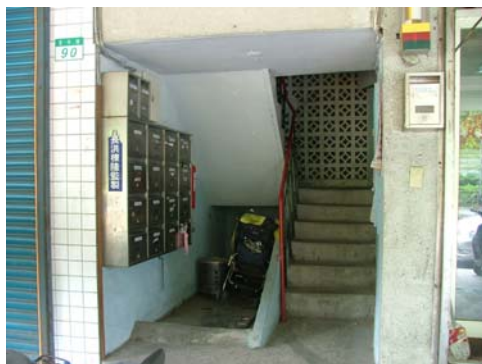
照片 4-21 主梯出入口現況
