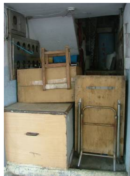
照片 4-22 副梯出入口現況
