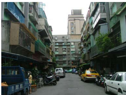
照片 4-19 社區內部道路佔用情形
