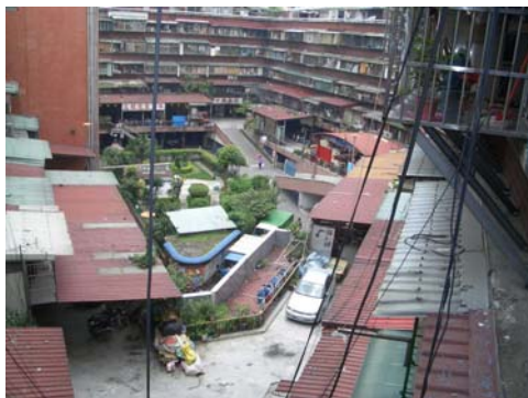
照片 4-1 社區 1F 違建情形
