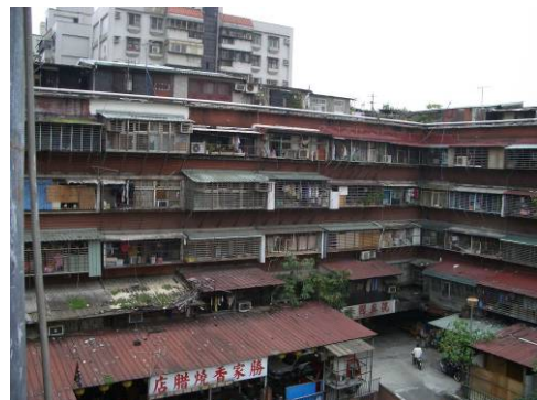
照片 4-2 社區 2~5F 違建情形
