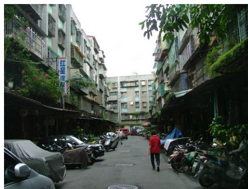
照片 4-20 社區內部道路佔用情形
