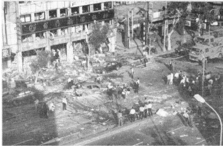
圖附錄 4-9 可磨坊餅店火災現場
