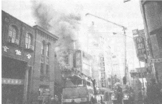
圖附錄 4-14 漢妮餅店火災現場
