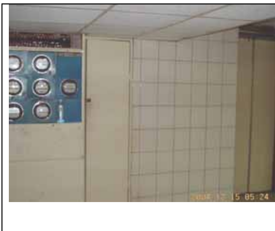
圖 5-1 管道間維修口
