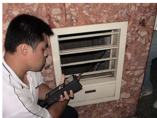
進氣口風速量測(2F)
