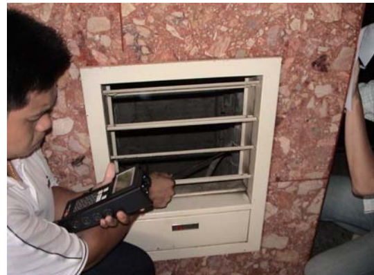
進氣口風速量測(21F)
