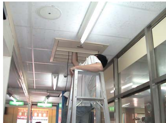
測量排煙風口流速
