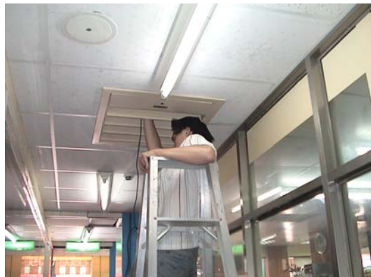
測量排煙風口流速
