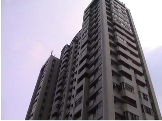
大樓建築物外觀
