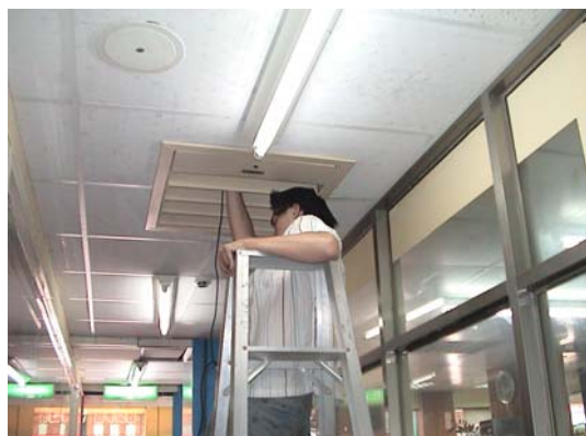
測量排煙風口流速
