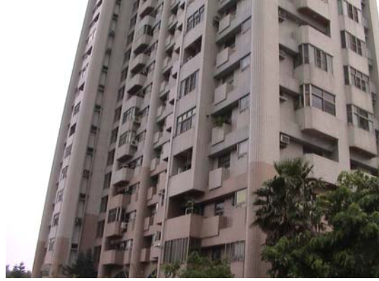
大樓建築物外觀
