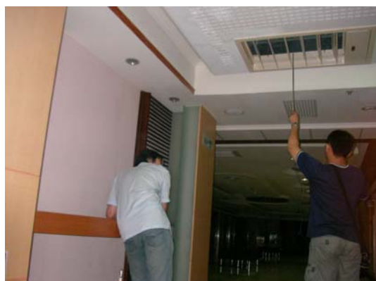
11F 排煙閘門風速量測
