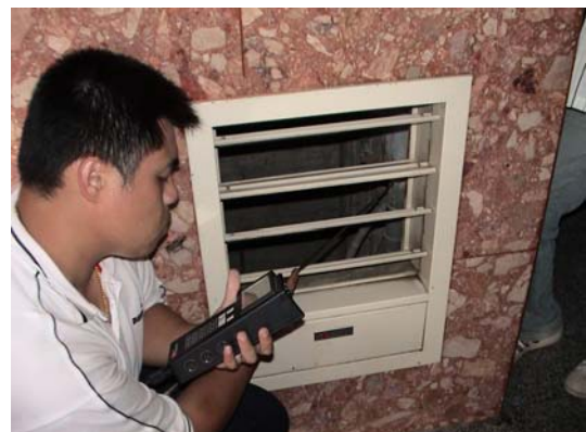
進氣口風速量測(2F)
