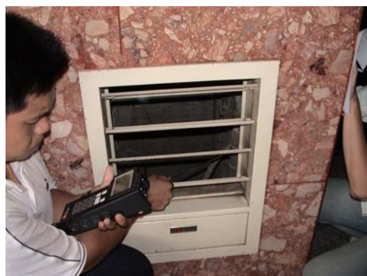
進氣口風速量測(21F)
