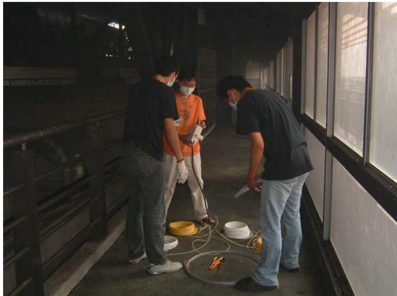
圖 3.2-9 安裝光電式分離型煙探測器之情形(2)
