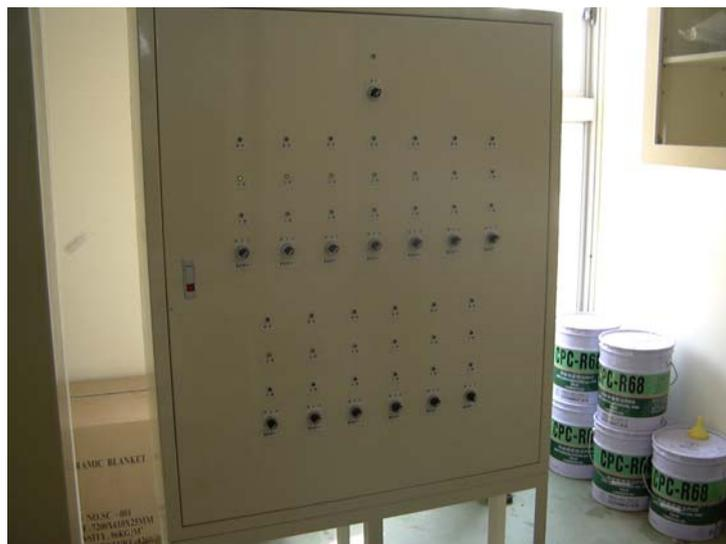
圖 3.1-11 監控室之排煙風機轉速控制盤
