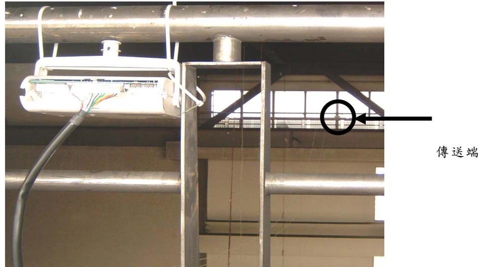
3. 差動式集中型熱探測器與光電式集中型煙探測器：兩者之安裝線路與實際場地配置圖示如圖 3.2-12 至圖 3.2-15。兩者之安裝線路圖與火焰偵測器相同。安裝於貓道兩側欄杆，高度約為 22 公尺。
