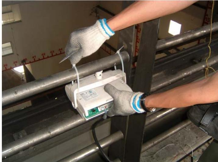
圖 3.2-10 第一組光電式分離型煙探測器於離地高 6 公尺處
