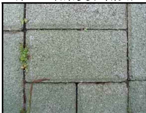
圖 3-29 較低處透水磚(阻塞)
