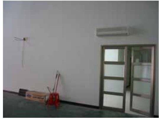
39.配光曲線會議室室內空調機
