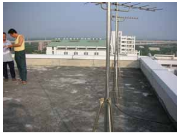
安裝前現勘 2—原有天線需更動位置、 周邊需加設欄杆
