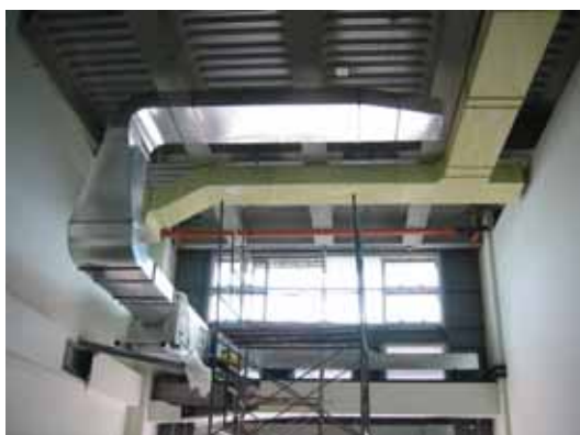
圖 2-8 配光曲線實驗室空調管線配置
