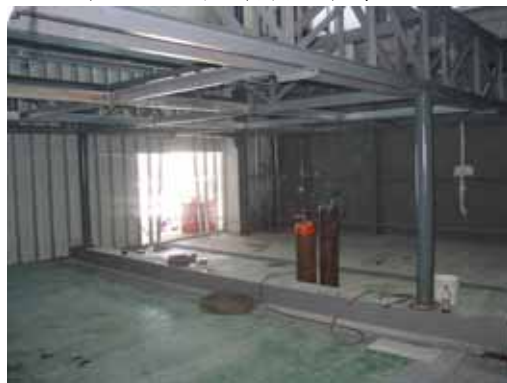
圖 3-63 活動天花板主架構施工
