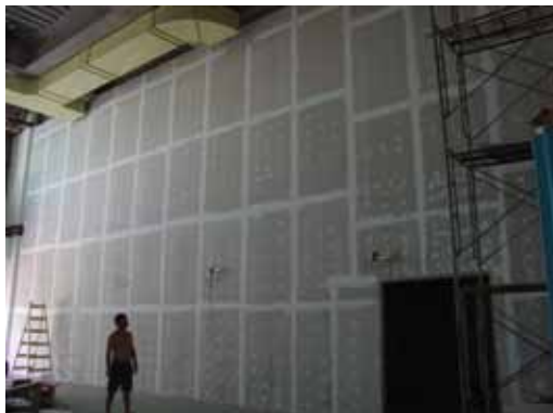
圖 3-71 隔間牆面粉刷施工
