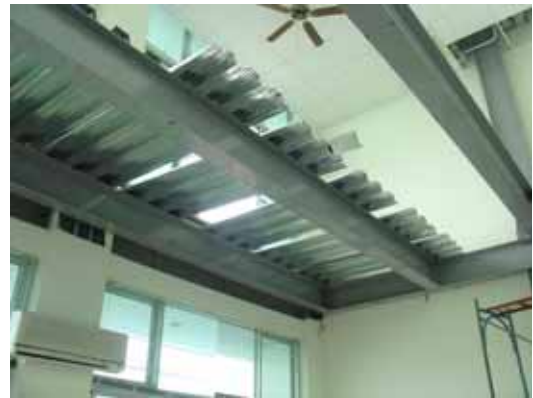
4.DECK 樓板厚 1.2mm(TYP.)（主體結構）
