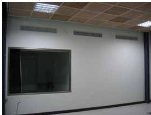
圖 3-6 空調系統側面回風
