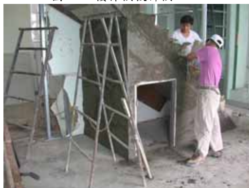
圖 3-41 樓梯模板拆模
