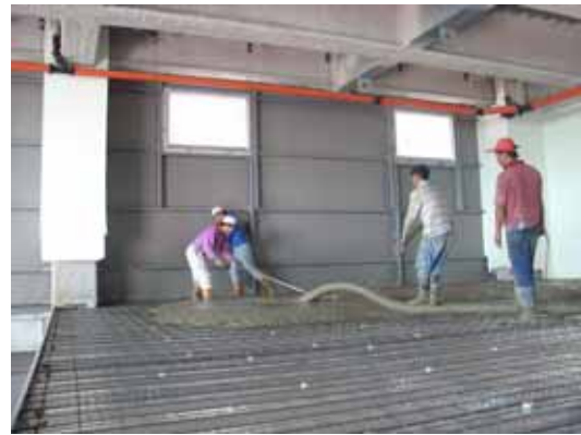
3.樓板灌混凝土（主體結構）
