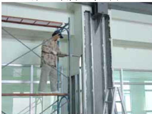
圖 3-26 原有矽酸鈣版拆除
