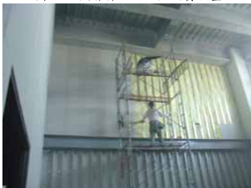
圖 3-44 隔音棉施工—照明實驗室
