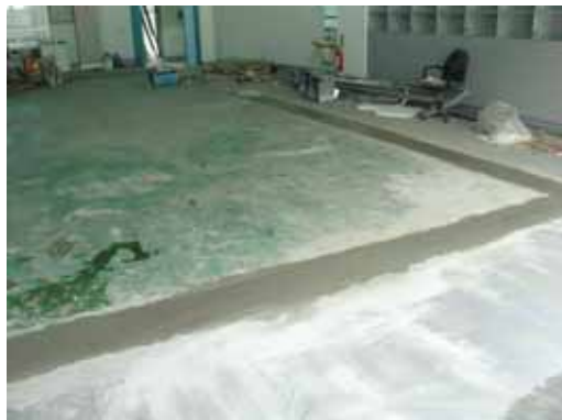
圖 3-38 浮動地板取消灌漿作業
