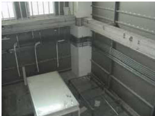
圖 3-56 空調管線配管施工
