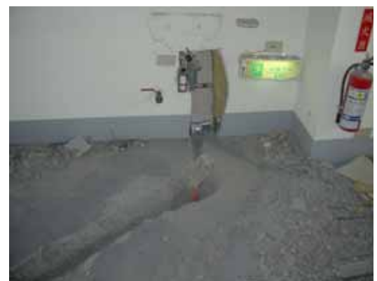
21.排水管線牽管
