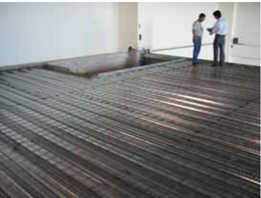
4.DECK 樓板厚 1.2mm(TYP.)（主體結構）
