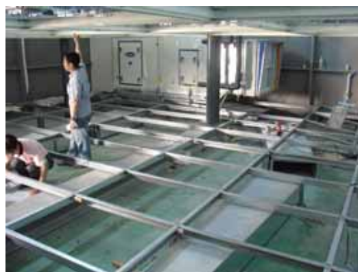
圖 2-9 照明實驗室地板式空調管線配置
