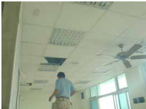
圖 3-48 T-Bar 型燈具安裝
