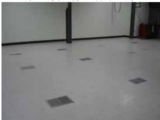
圖 3-5 高架地板地面出風口設計
