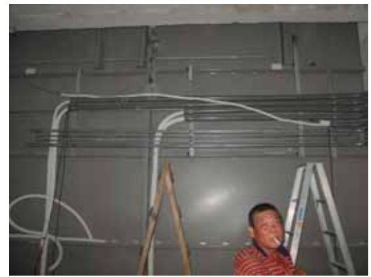
19.空調配線工程
