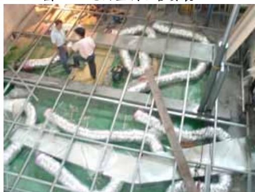
圖 3-65 地面空調配管安裝
