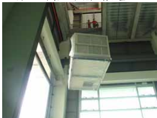
圖 3-55 吊裝空調設備至實驗室
