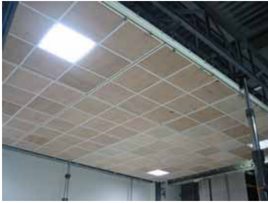
14.T-bar 明架輕鋼架、2'x2' T-bar 燈具
