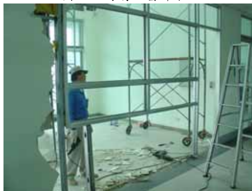
圖 3-27 原有鋁窗拆除
