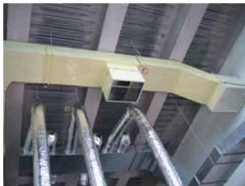
圖 2-15 依照實驗空間調整後預留排煙系統
