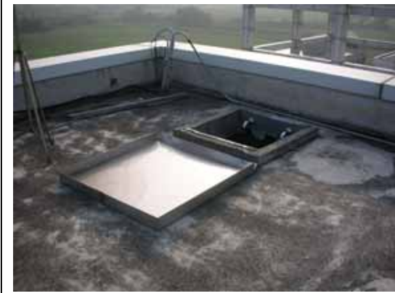
安裝前現勘 1—屋頂平台出入口
