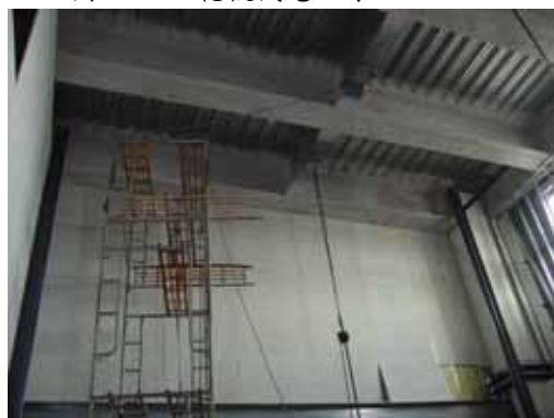
圖 3-51 天花板機電配線施工
