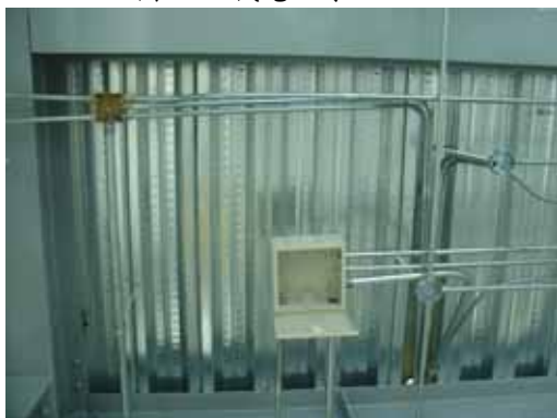
圖 3-50 機電配線施工
