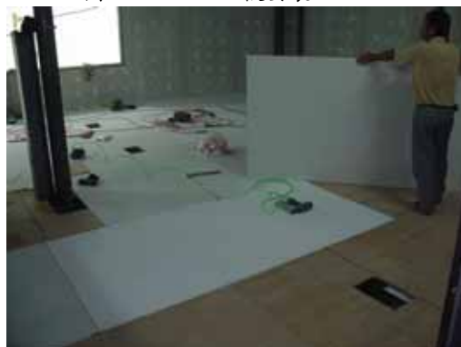
圖 3-61 PVC 地板安裝施工 2
