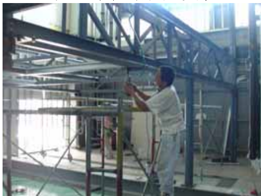
圖 3-62 升降天花板軌道安裝
