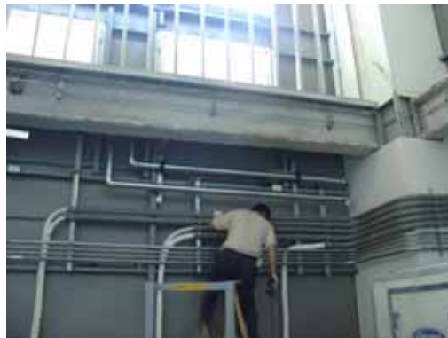
圖 3-57 空調設備室內外機安裝配管
