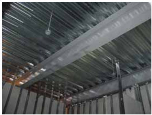
18.電燈管線佈線工程
