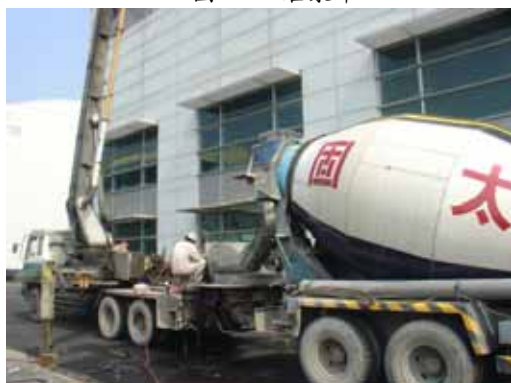
圖 3-38 浮動地板取消灌漿作業
