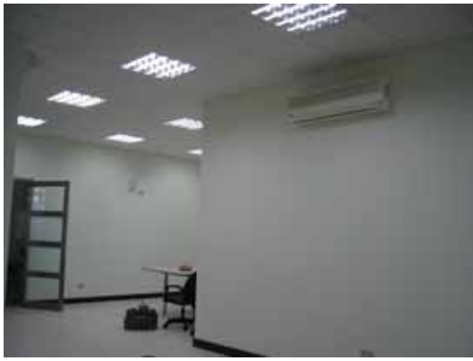
22.照明系統—T-BAR 型日光燈
