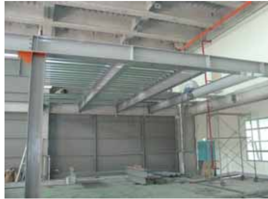
1.補強樑柱 H 型鋼、螺栓（主體結構）
