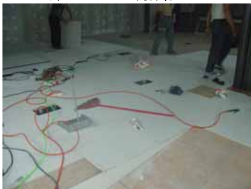
圖 3-60 PVC 地板安裝施工 1
