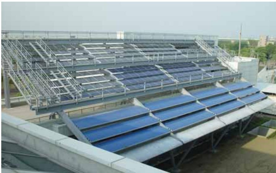
圖3-2 設備館架設太陽能光電板及遮陽板完工圖
