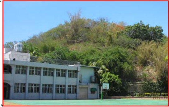
照片 3-6 壽山國小旁舊崩坍地
