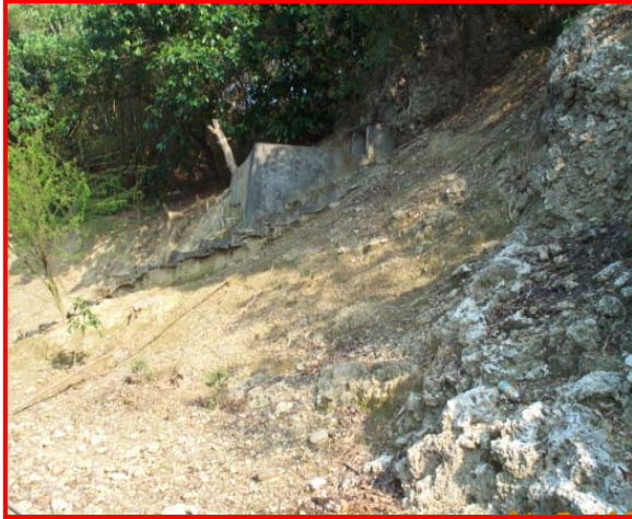
照片 4-13 大坪頂社區受損邊坡
