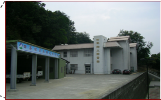
照片 3-16 田寮鄉公所西側邊坡
