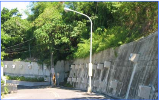
照片 3-2 桃源里聯外道路邊坡擋土
