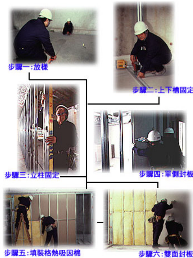
圖 16 隔間牆新建之施工流程
