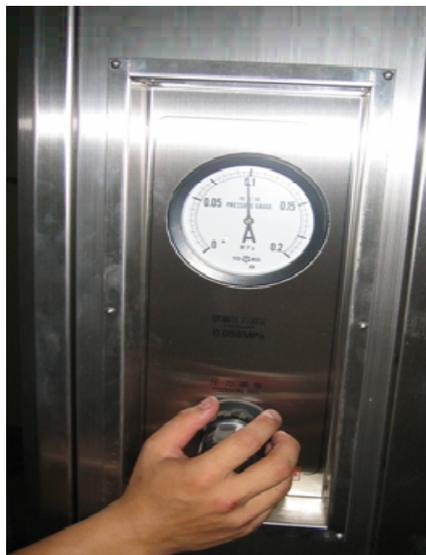
圖 4-4 噴霧壓力旋鈕調整
