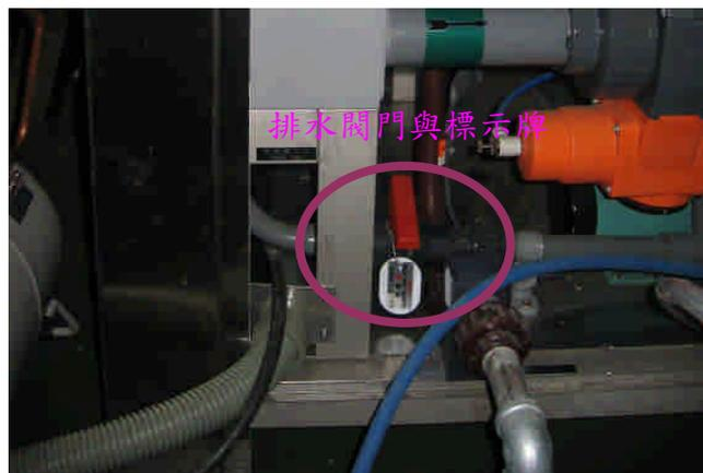
圖 5-6 浸漬溶液儲存槽排水閥門與標示牌
