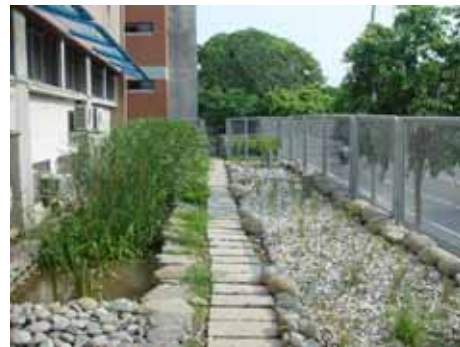
圖 2-8 表層下流動系統完工
