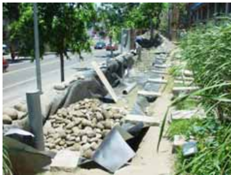
圖 2-7 表層下流動系統 施工現況
