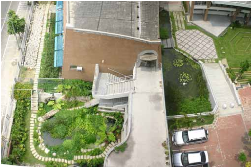
圖 3-20 人工濕地實驗場全景
