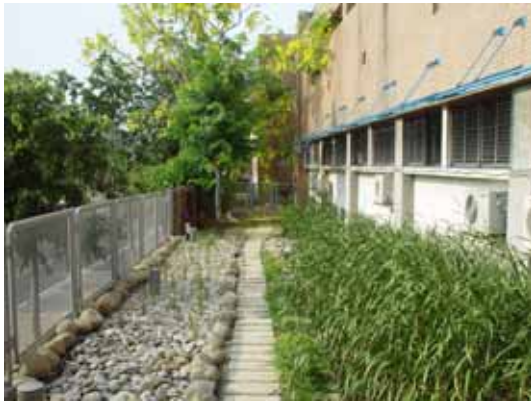
圖 1-2 SSF 系統及 FWS 系統
