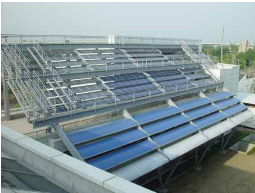
圖七. 設備館架設太陽能光電板及遮陽板完工圖
