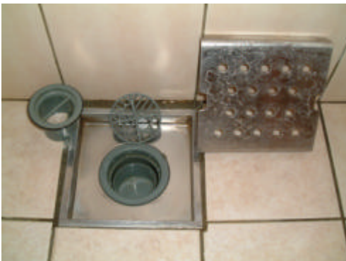
圖 3-1-1 浴室地板落水器具分解構造
