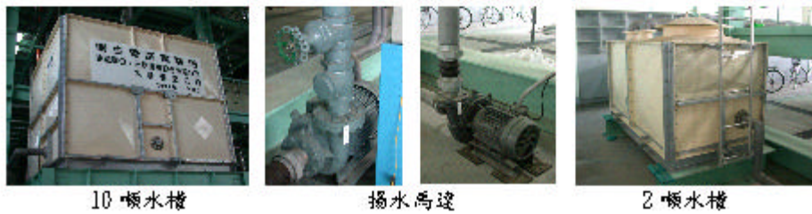
圖 3-2-2 衛生管路實驗設施構成圖 [4][7]
