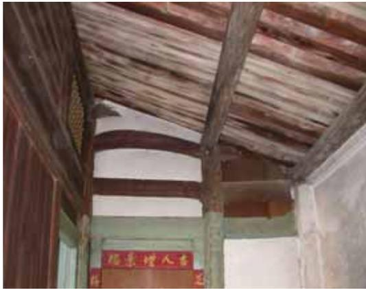
圖 3-11 穿材直接與牆面相接
