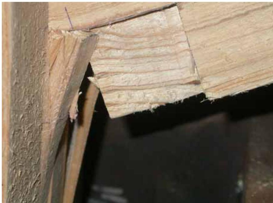
圖 4-9 柱材燕尾榫眼部分發生外翻，梁被拔出
