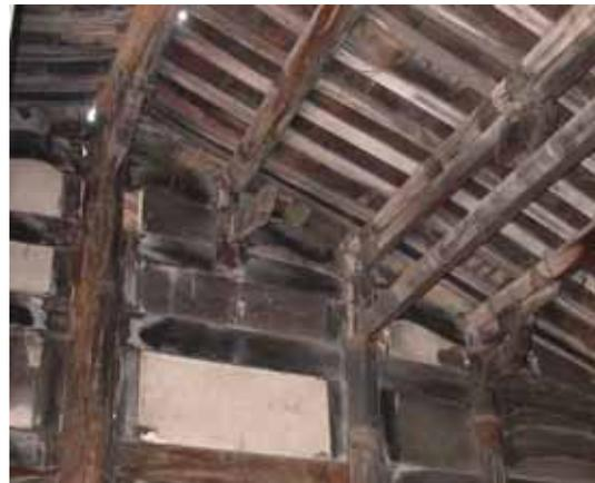
圖 3-18 透過榫卯系統與柱材
