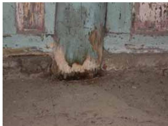
圖 3-2 柱材直接接地
