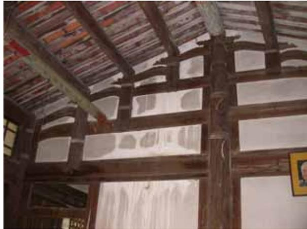
圖 3-19 燈梁架在穿材上端
