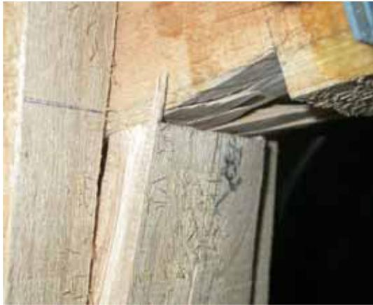
圖 4-7 柱材鉤逗部位發生破壞
