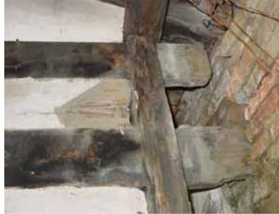
圖 3-12 牆體內磚材腐朽狀況
