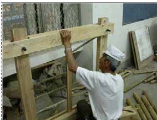
圖 3-20 以傾斜方式將籬梗另一端置入邊框內。
