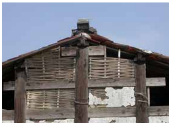
圖 3-5 山牆部編泥牆骨架做法
