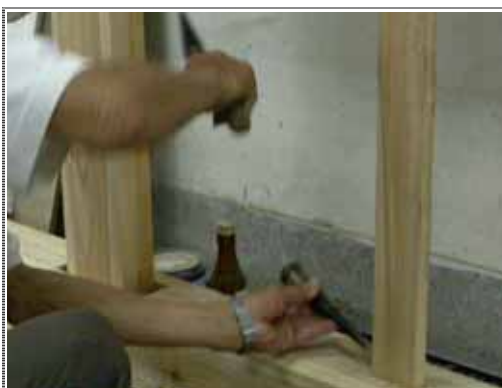
圖 3-18 許復春匠師以 8 分「刺仔」及鐵鎚於壁體邊框或暗梗之一端敲出刻痕。
