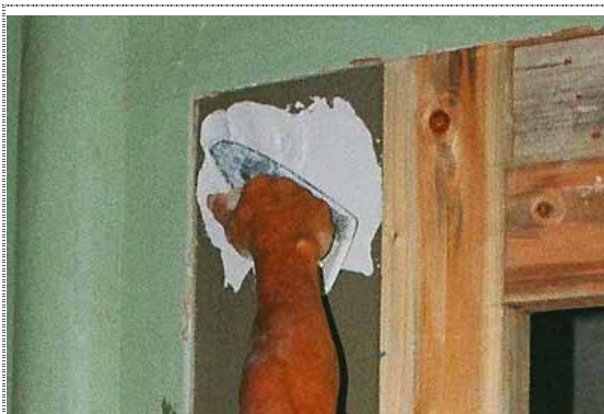
圖 3-34 新營太子宮匠師先以鐵製抹刀在壁面上抹上白灰。
