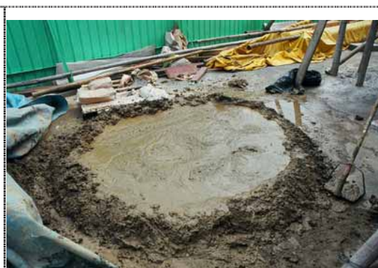
圖 3-28 黏土與米糠充分混和攪拌後之情形。
