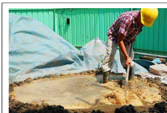
圖 3-27 新營太子宮之修護施作實例，么土過程。
