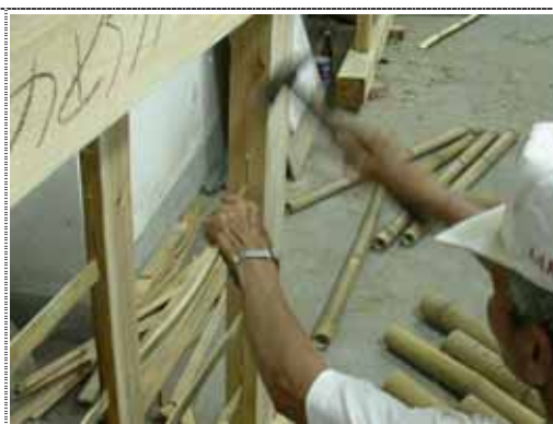
圖 3-21 直接以鐵鎚敲由上往下或由下往上敲入邊框中直到籬梗與地面平行。
