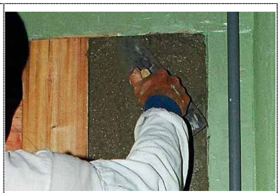
圖 3-30 新營太子宫匠師以鐵製抹刀將壁面稍
