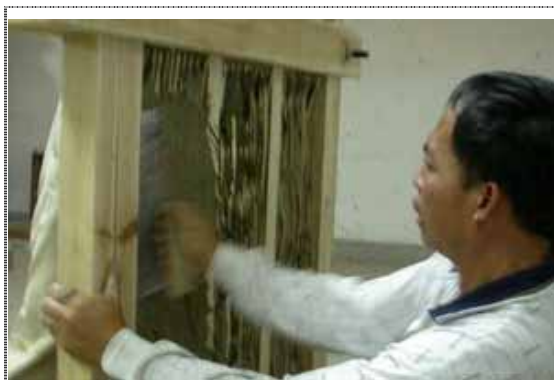
圖 3-29 劉聰連匠師將以抹刀將米糠土壓入壁體
