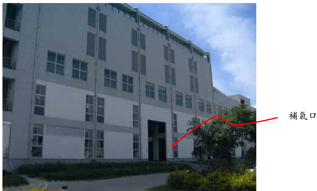
圖 2-2.9 綜合實驗室之西側補氣口開啟情形
