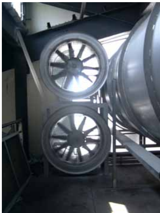
圖 2.2-6 貓道上之小型軸流式風機裝置方式
