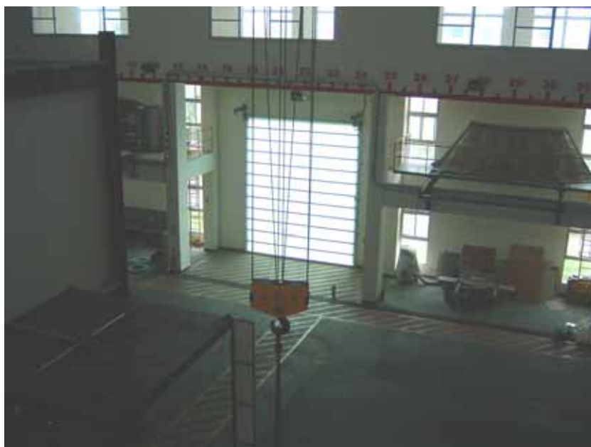
圖 2-2.8 綜合實驗室之西側補氣口關閉情形
