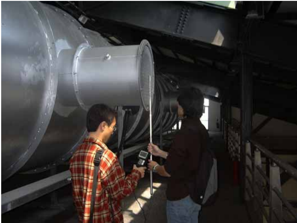
圖 3.1-1 於排煙口附近量測風速之情形
