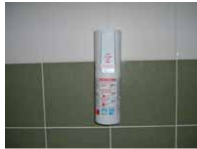
圖 5.11 廚房專用滅火器
