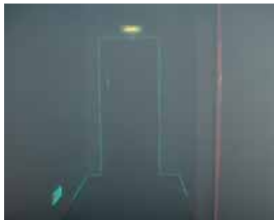
圖 5.44 全方位逃生引導系統
