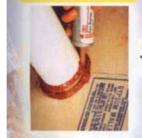
圖 5.47 防火泥填塞
