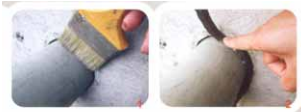
圖 5.46 防火材料填塞
