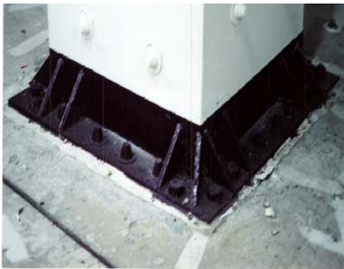
樓版上方之柱腳基座
