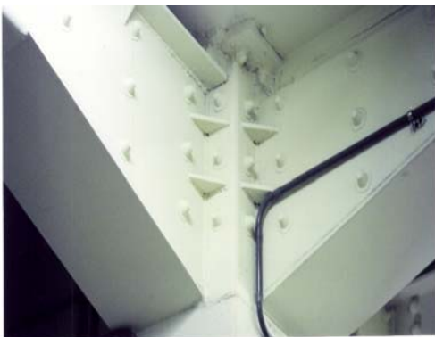
樓版下方之柱頭貫穿螺栓
