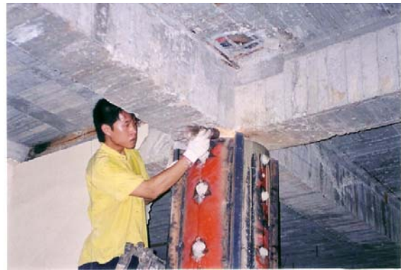
圓柱四個角隅的樓版敲除
