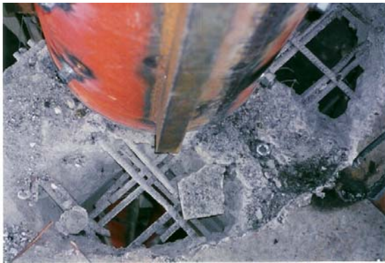
圓柱四個角隅的樓版敲除
