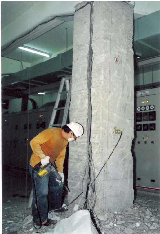
(a) 柱粉刷層敲除
