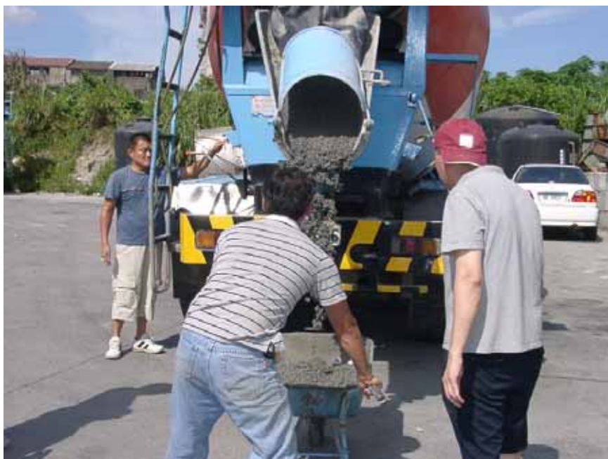
圖 4-28 廠拌凹型試驗-混凝土預拌車拌和
