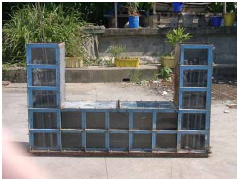
圖 4-29 廠拌凹型試驗-凹型模具及鋼筋組合
