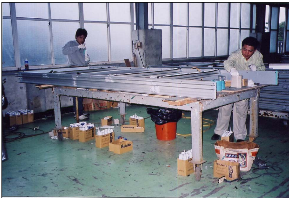
[圖 3.23] 框架組立-直橫料鎖固
