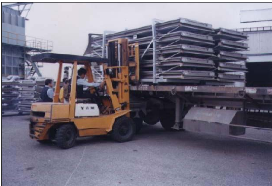
[圖 3.31] 單元裝車 (依安裝順序流水編號由上而下疊放)
