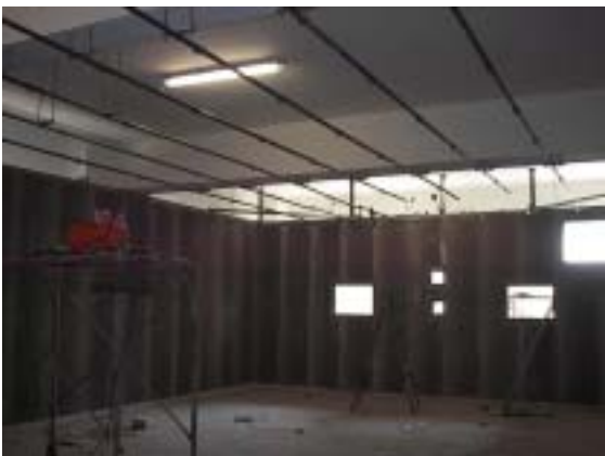
圖 5-5 架設中之撒水管路
