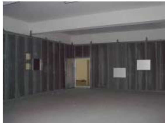
圖 5-4 實驗場內部 ( 已架設完成之隔板 )
