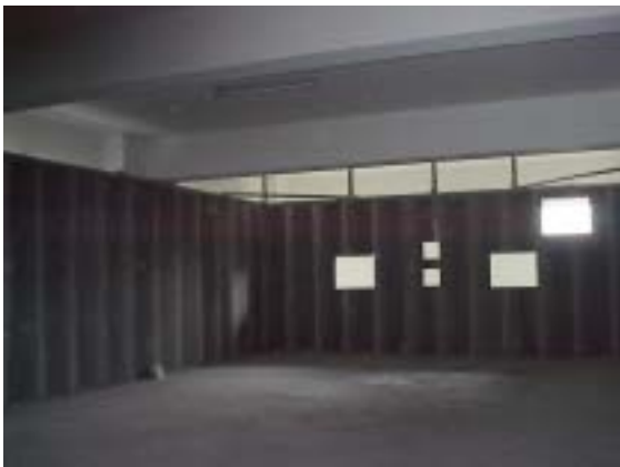
圖 5-3 實驗場內部 ( 已架設完成之隔板 )
