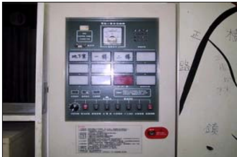
圖 5.10 火警自動警報設備之受信總機
