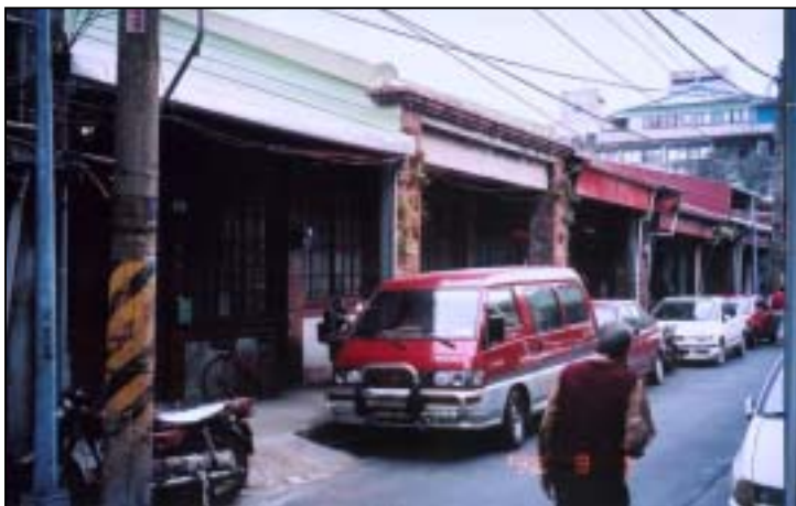
附錄圖 5.8 勘查照片之五（磚木瓦造住宅共柱、樑、壁結構）
