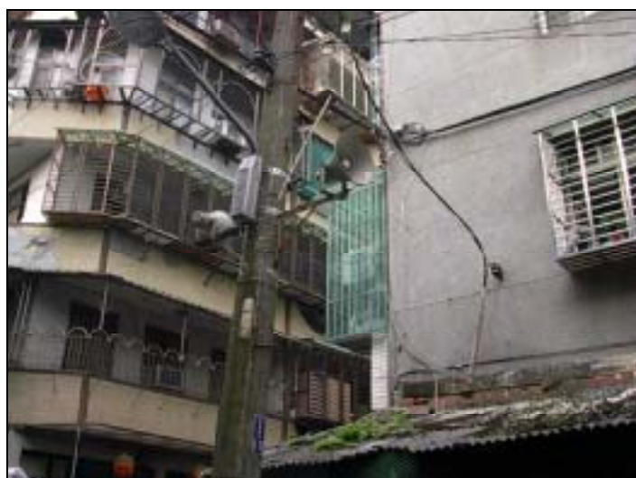
圖 5.31 公館口現有之廣播設備
