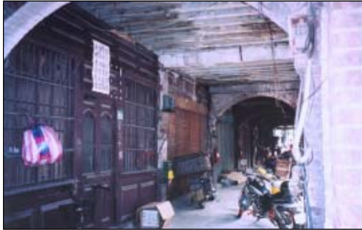
附錄圖 5.6 勘查照片之三（磚木瓦造之古蹟平房結構）
