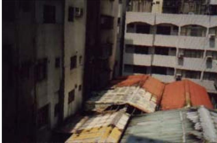
圖 3-9 牆壁混凝土火害受損圖
