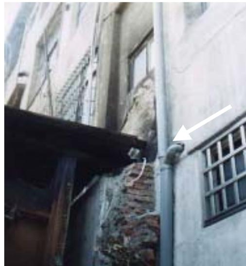
圖 3-8 牆壁混凝土火害受損圖
