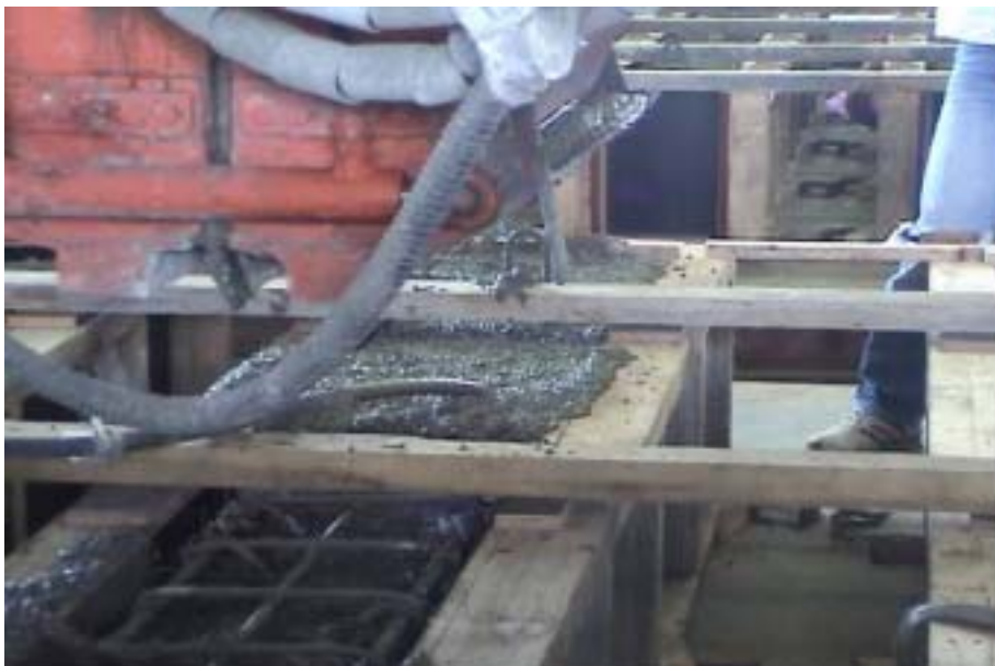
照片 4-3.11 澆置梁試體混凝土情形
