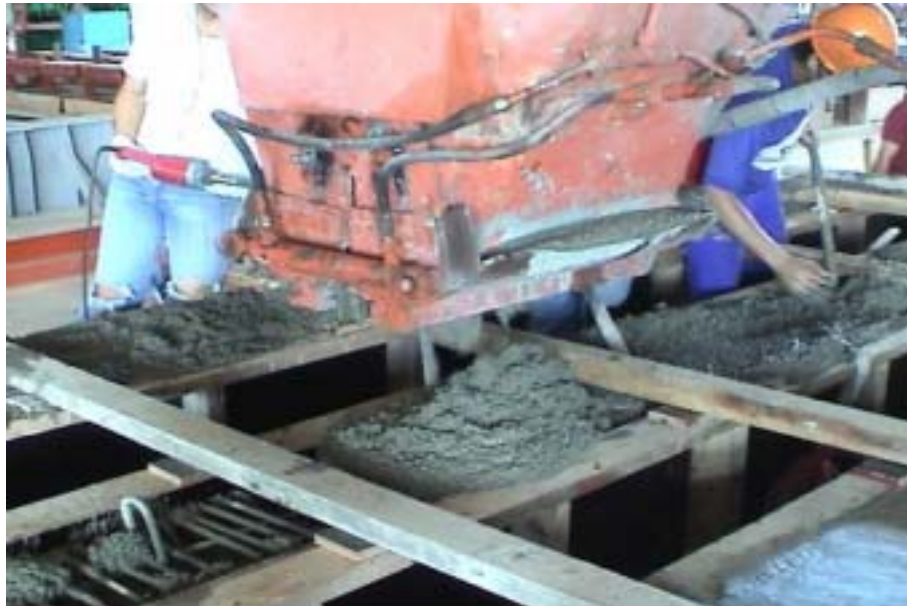
照片 4-3.14 澆置梁試體混凝土情形
