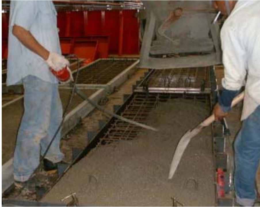
照片 4-2.21 坍度改 8 公分時即使用震動機亦無明顯顆粒隆起現象(一)
