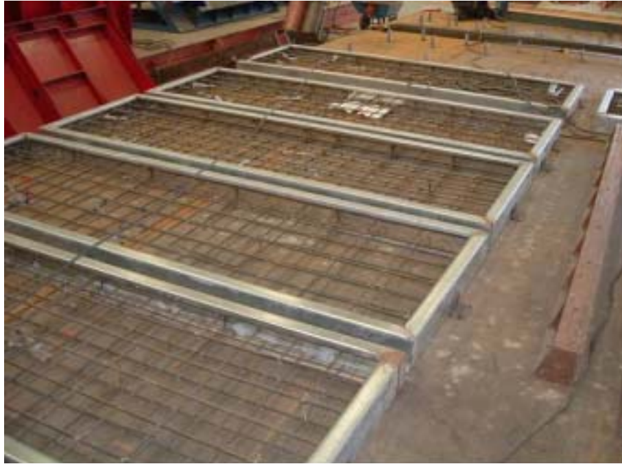
照片 4-4.1 鋼筋綁紮
