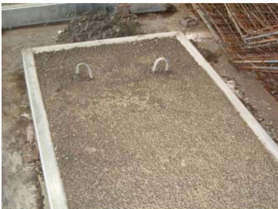
照片 4-2.20 使用配比 92.06.06-3 配比灌製構件時有顆粒隆起現象(二)
