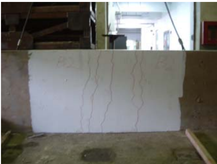
照片 4-4.20 SB2 試體試驗後裂縫發展情形
