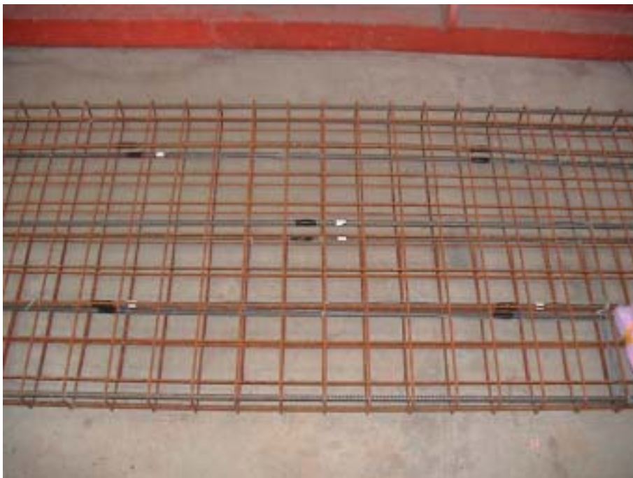
照片 4-6.2 抗彎試驗牆試體之配筋
