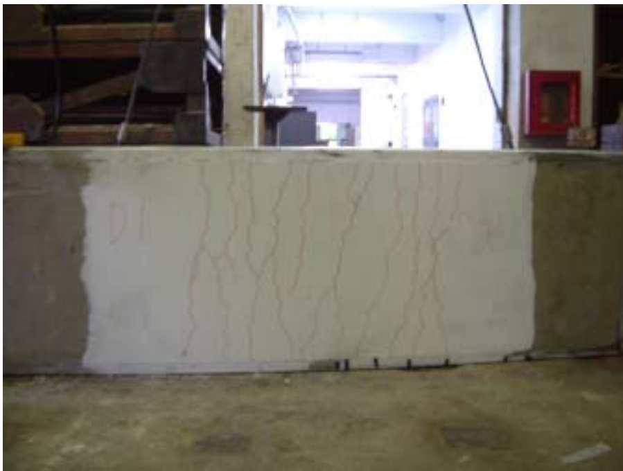
照片 4-4.24 SD1 試體試驗後裂縫發展情形
