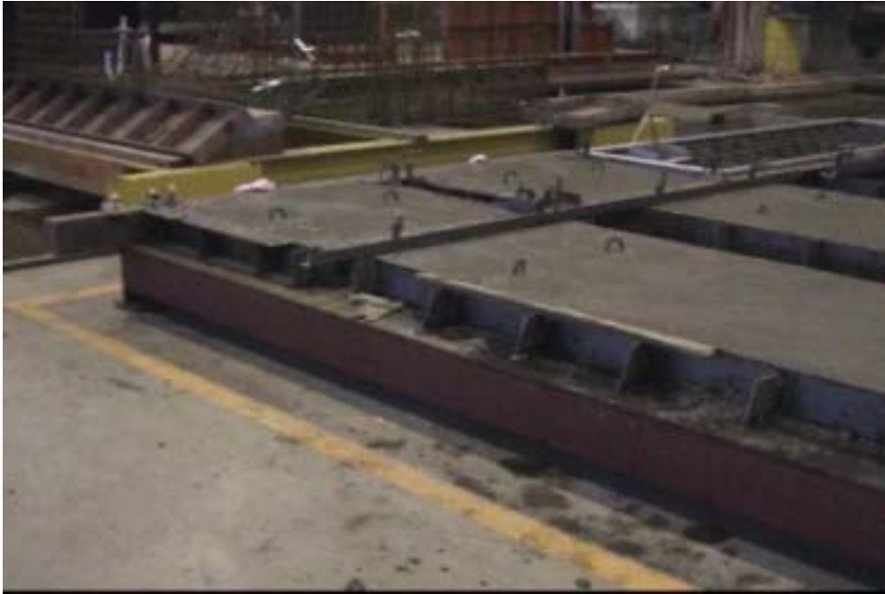
照片 4-6.3 抗彎試驗牆試體灌注之情形
