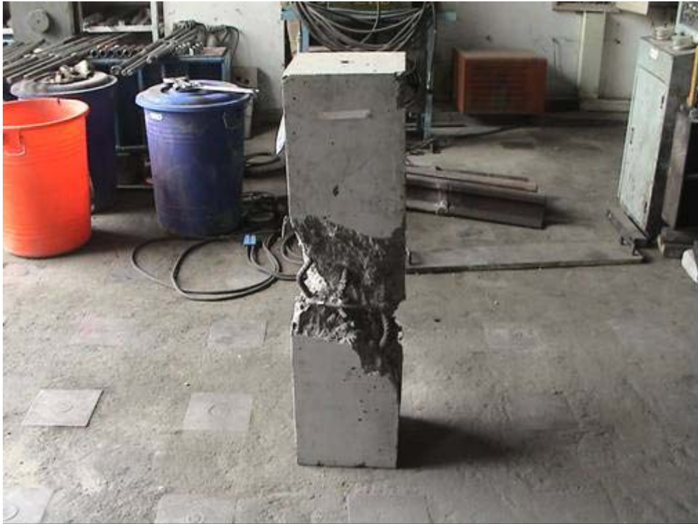
照片 4-5.11 NC1 破壞狀況
