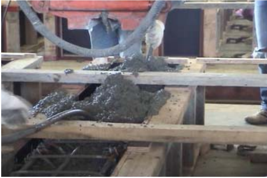
照片 4-3.10 澆置梁試體混凝土情形
