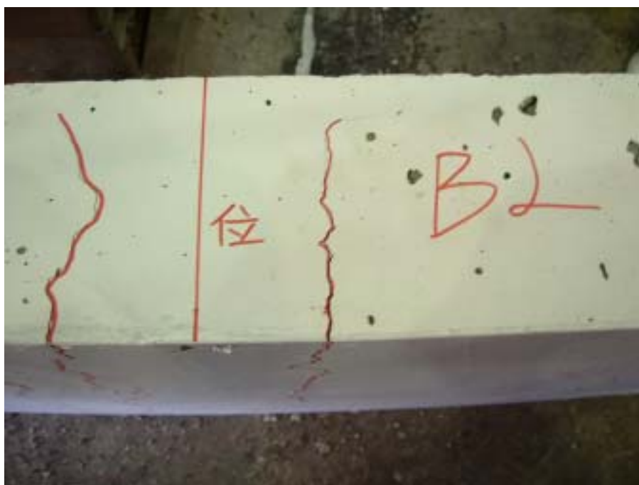
照片 4-4.21 SB2 試體試驗後裂縫發展情形
