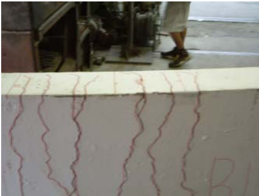
照片 4-4.19 SB1 試體試驗後裂縫發展情形
