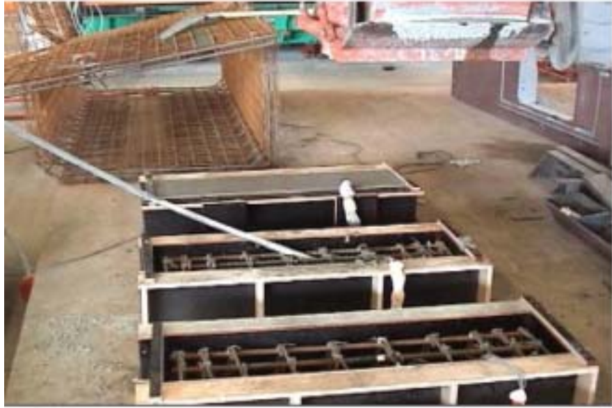
照片 4-5.3 柱試體在工廠灌注之情形
