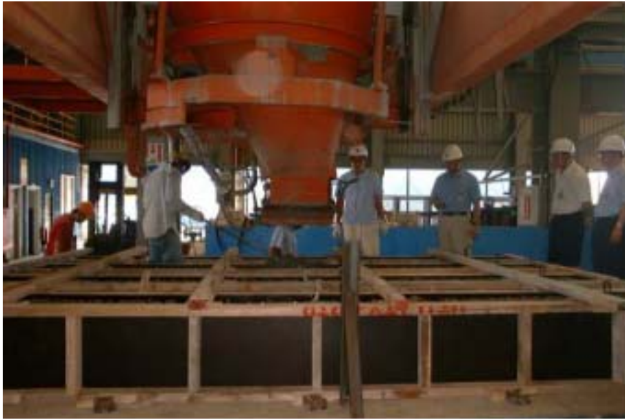
照片 4-3.12 澆置梁試體混凝土情形
