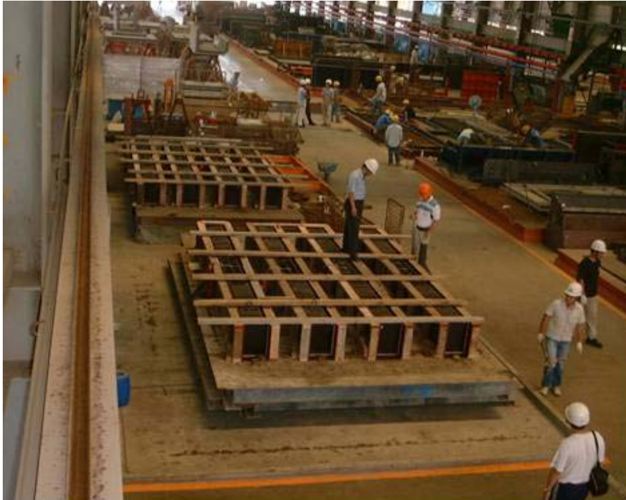
照片 4-3.4 模版組立完成及澆置混凝土作業平台配置情形
