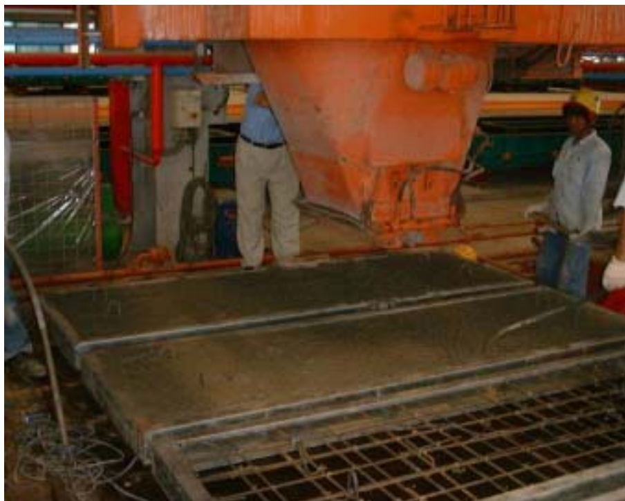
照片 4-2.22 坍度改 8 公分時即使用震動機亦無明顯顆粒隆起現象(二)
