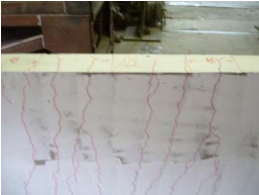
照片 4-4.17 SA2 試體試驗後裂縫發展情形
