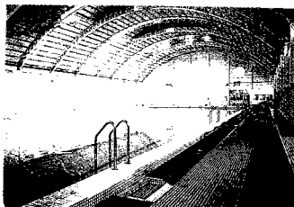
圖 3-24 室內游泳池的屋頂蓋可移動(輔仁中學)
