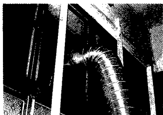
圖4-51 抽油煙機之排氣管
