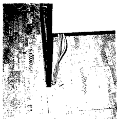
圖4-80 隱藏式電源接駁(浮式地板)，亦可防潮。
