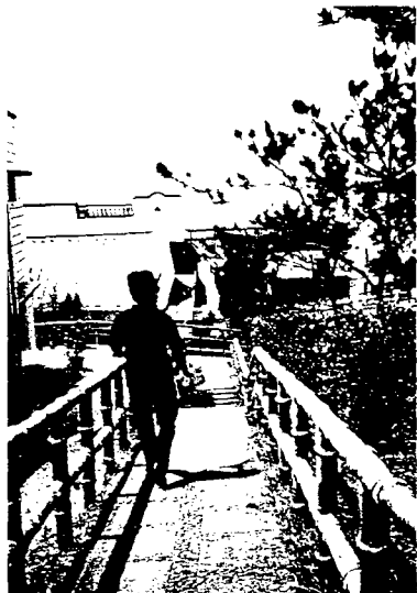
圖 4-11 仿木扶手坡道
