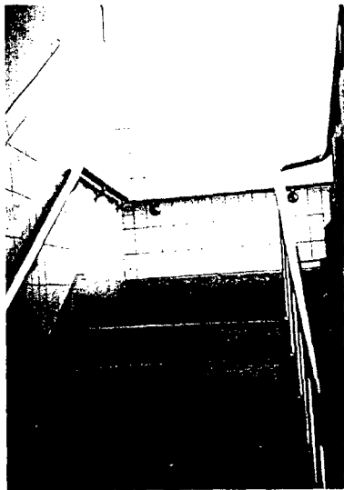
圖 4-12 樓梯兩側扶手
