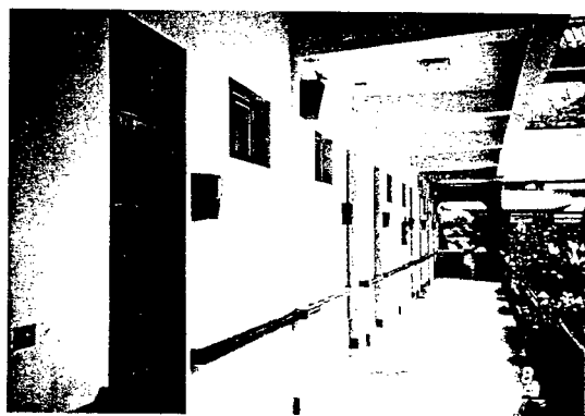
圖 4-20 走廊陽台欄杆
