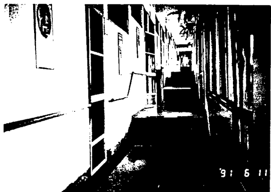
圖 4-3 單邊走廊木質扶手
