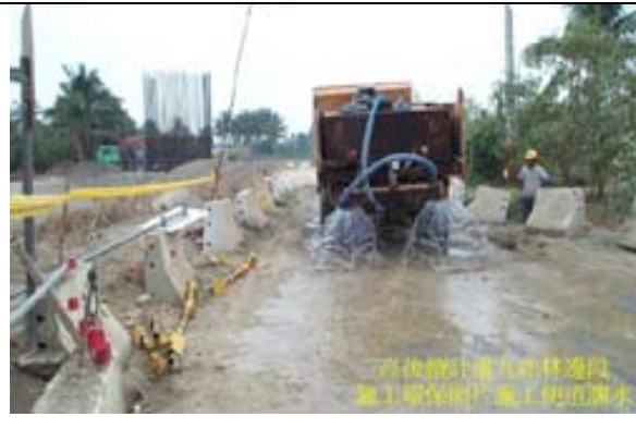
(圖 3-24) 工地隨時洒水減少粉塵
