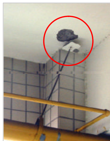
照片 3.16 連混凝土塊一同拔出
