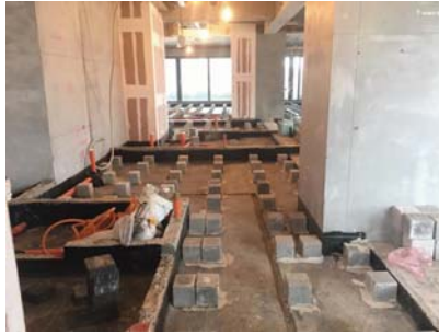
北部集合住宅案-高架地板配合現場改管實例
