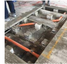
北部集合住宅案-高架地板配合現場改管實例
