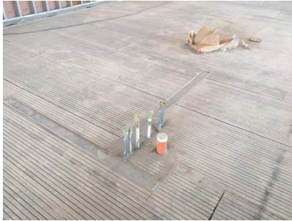
北部集合住宅案-高架地板配合現場改管實例
