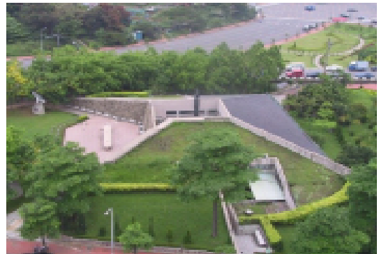
圖1.4(右) 嘉義市二二八紀念館覆土建築與雙層牆通風除濕設計，可建議在生物多樣性、日常節能兩指標上可各加2分
