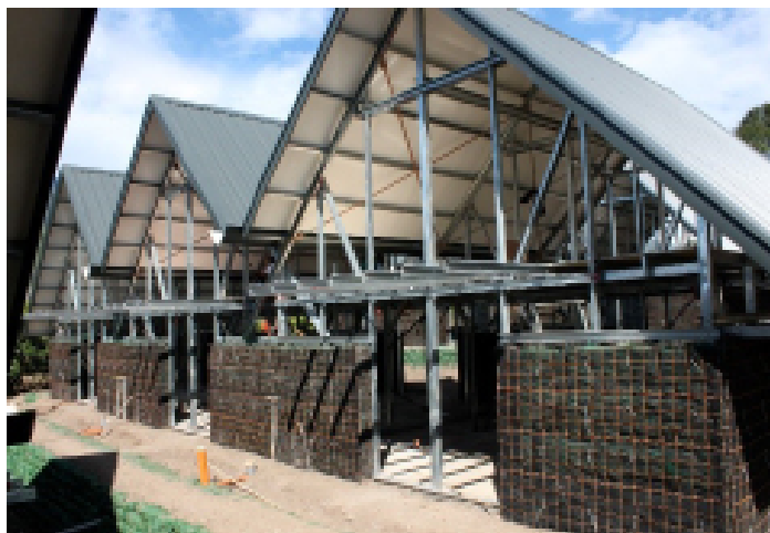
圖1.5 採以工代賑完成的輕鋼構造八八風災重建永久屋，建議在CO 2 減量、廢棄物減量等指標上可被認定為滿分
