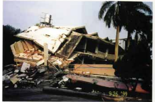
照片編號1.70 光復國中校舍崩塌情形
