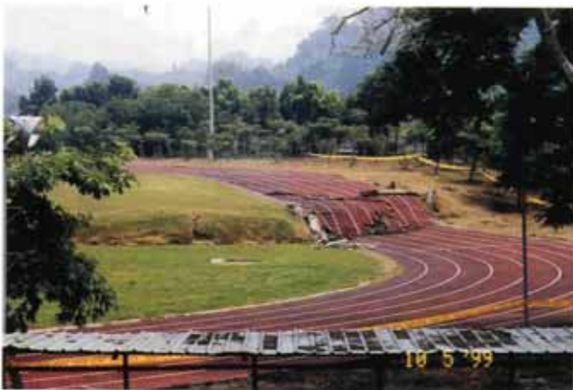
照片編號1.69 車籠埔斷層通過霧峰光復國中運動場造成1.5米左右之隆起
