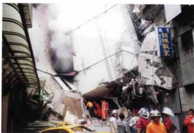
照片編號1.79 台北縣新莊博士的家，建築物傾頽損及鄰房，建築物內發生火災
