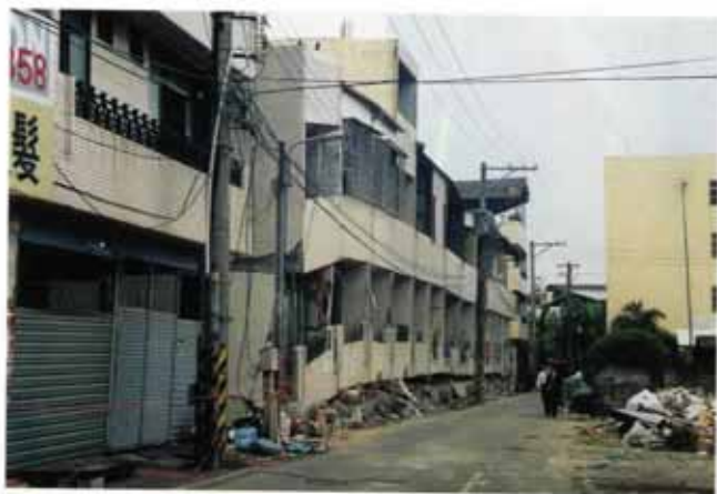
照片編號1.56 台中縣豐原市部份民宅，建築物一、二樓場陷毀壞
