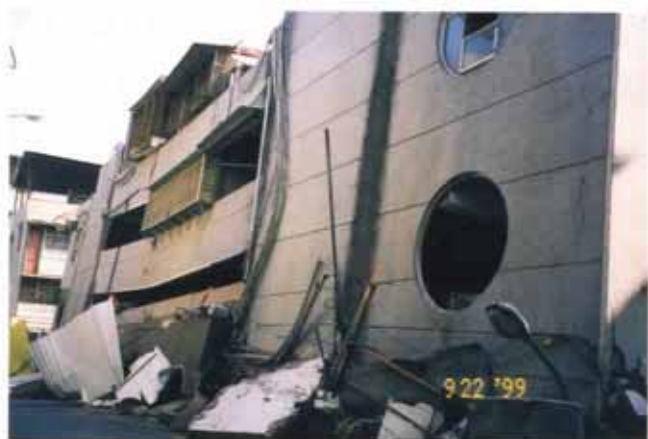
照片編號I.98 嘉義力行市場因軟弱底層崩塌
