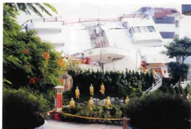
照片編號1.47 位於豐原市山區之豐原佛寺，在 921 大地震中全部倒塌，並造成鄰棟靈骨塔存放之骨灰罈架傾倒
