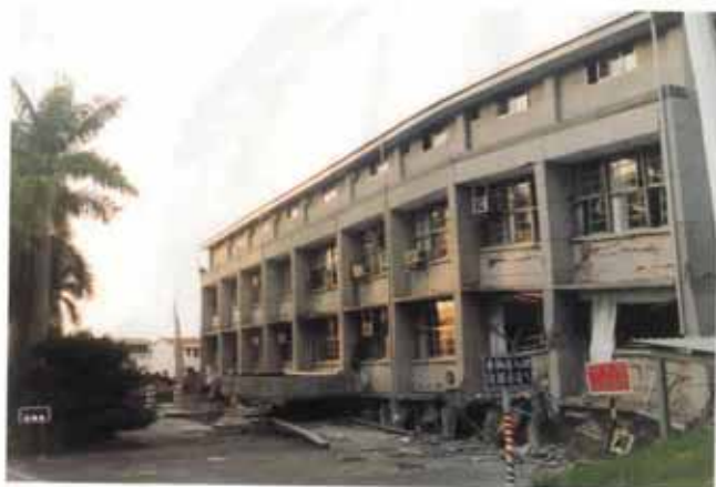
照片編號1.17 原省府法規會頂樓增建一樓整體壓毀破壞
