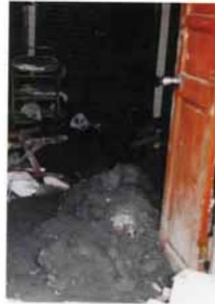
照片編號2.16 員林鎮員水路屋內嚴重沙湧
