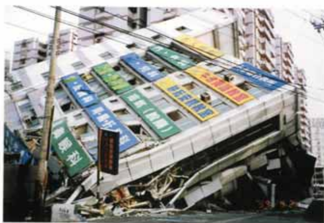
照片編號1.90 員林國宅旁一棟綜合用途大樓倒塌
