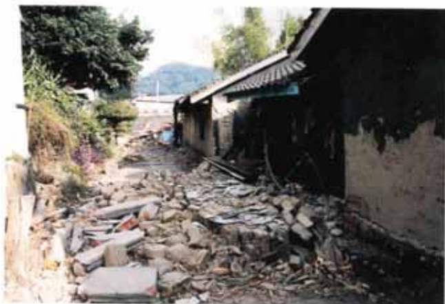
照片編號2.19 土塊層破壞情形(一)
