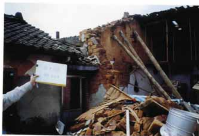
照片編號1.78 老舊建築——土塊厝倒塌近照
