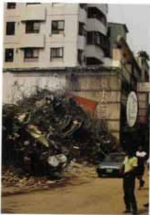
照片編號1.61 金巴黎損壞建築拆除後之景象
