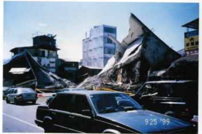
照片編號1.23 埔里鎮中山路兩側民宅倒塌嚴重
