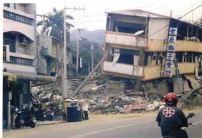
照片編號1.52 台中縣豐原市水源路民宅，因斷層通過地表受擠壓隆起，導致建築物傾斜而毀壞
