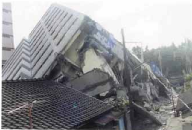
照片編號1.91 員林國宅旁10層樓建築物，一樓斷裂整體傾倒破壞
