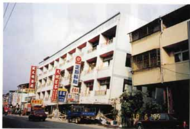
照片編號1.27 國姓鄉民宅一樓塌陷情形
