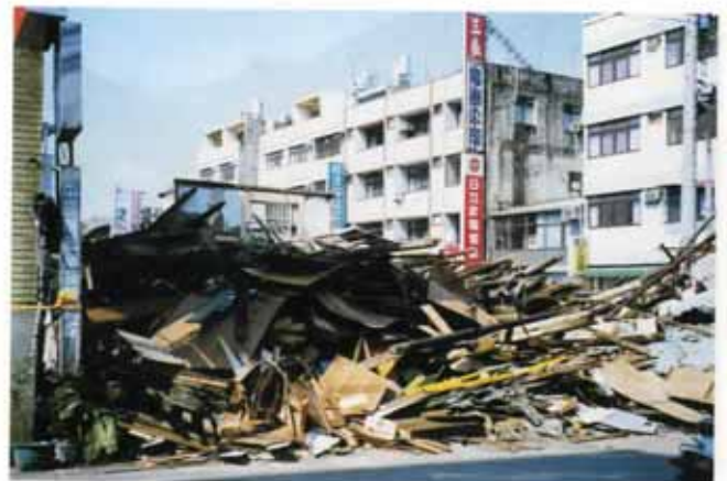
照片編號2.18 老舊木造建築毀壞情形
