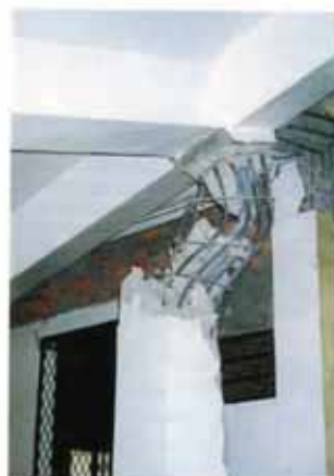
照片編號2.6 箍筋間距太大
