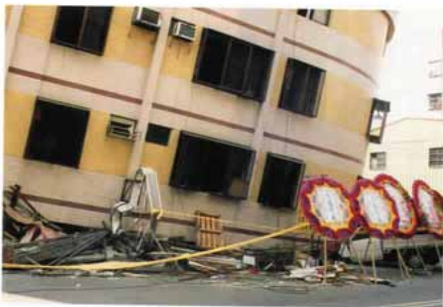
照片編號1.63 大里市騎樓式建築，一樓軟弱層崩塌
