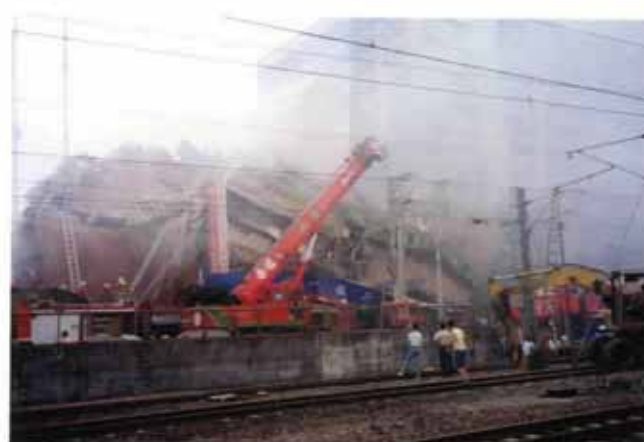
照片編號1.84 台北市東星大樓內發生火災
