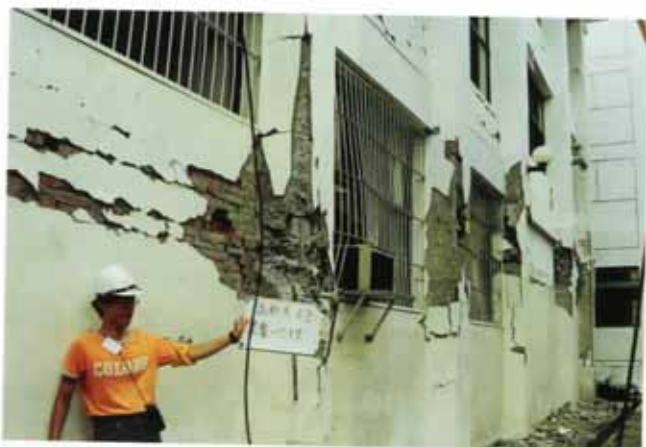
照片編號1.31 集集警察局後側外柱短柱效應（高科大 KFUI3017d）
