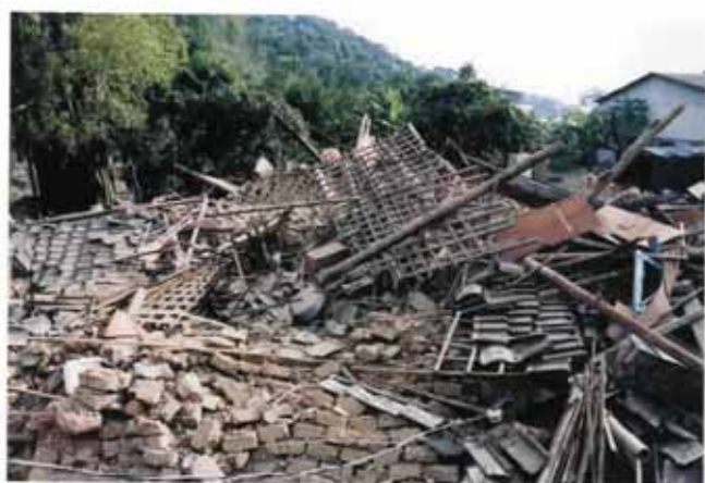
照片編號2.21 土塊層破壞情形(三)
