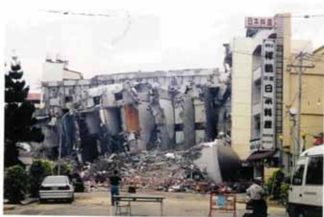
照片編號1.55 台中縣豐原市向陽永照大樓傾倒情形
