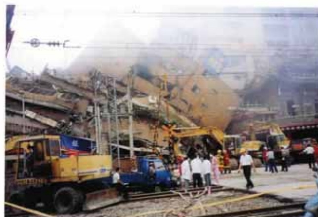
照片編號1.83 台北市東星大樓低樓層壓毀，高樓層傾頽
