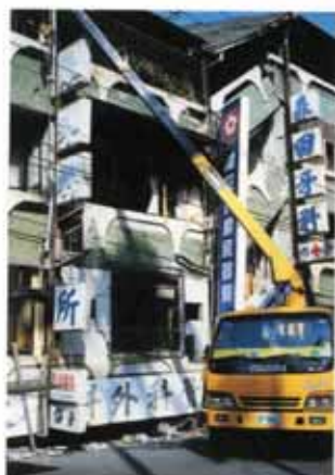
照片編號2.1 一樓軟弱層(騎樓)
