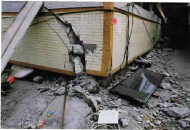
照片編號1.38 軟弱底層，一樓柱完全壓碎（台大草032）
