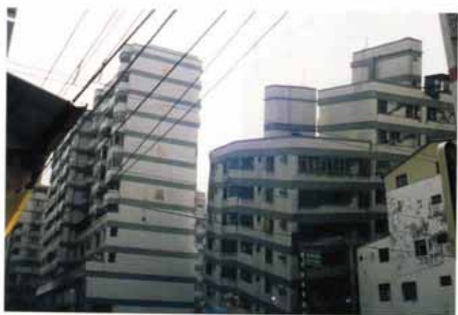
照片編號1.57 台中王朝建築傾倒，危及鄰棟安全
