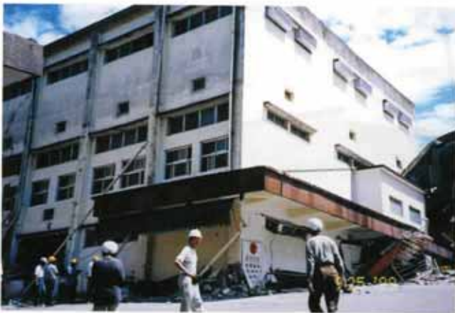
照片編號1.21 埔里酒廠部份場陷側傾情形
