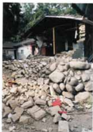
照片編號2.20 土塊層破壞情形(二)
