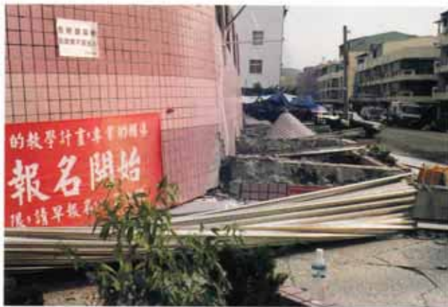
照片編號1.68 霧峰騎樓建築，一樓產生破壞(二)
