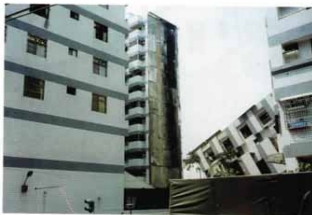
照片編號1.59 台中奇蹟建物因場陷而傾倒
