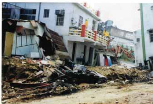
照片編號1.50 台中縣豐原市水源路68巷因斷層經過，導致建築物傾斜或嚴重破壞
