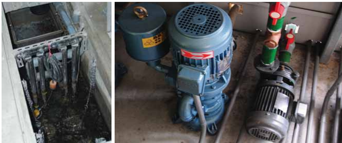
附圖 2-11 抽水泵浦實例
