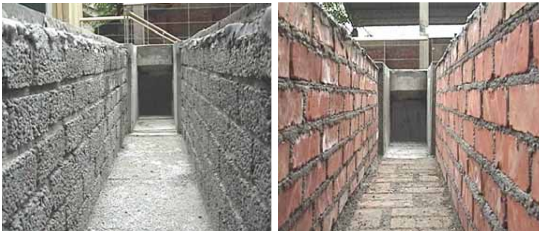
附圖 1-3 滲透側溝渠實例
