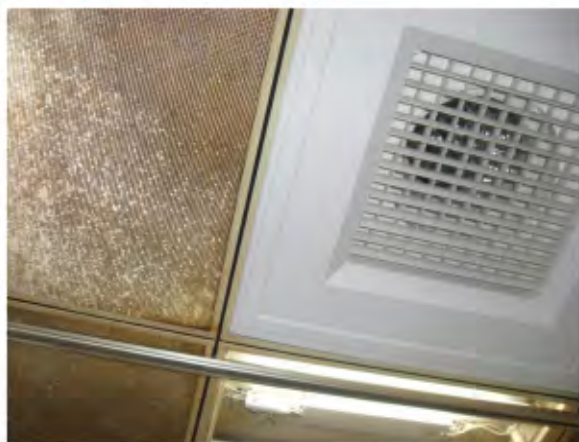
廁所加裝排氣風口
