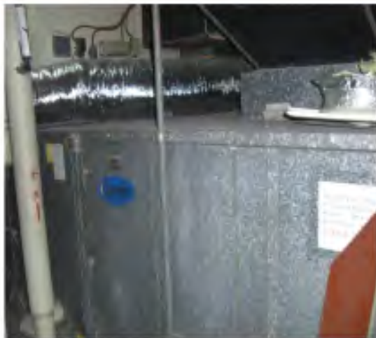
南棟舊有空氣箱
