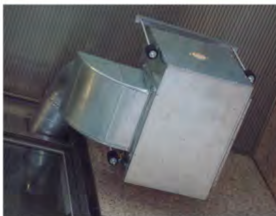
增設廁所排氣風機
