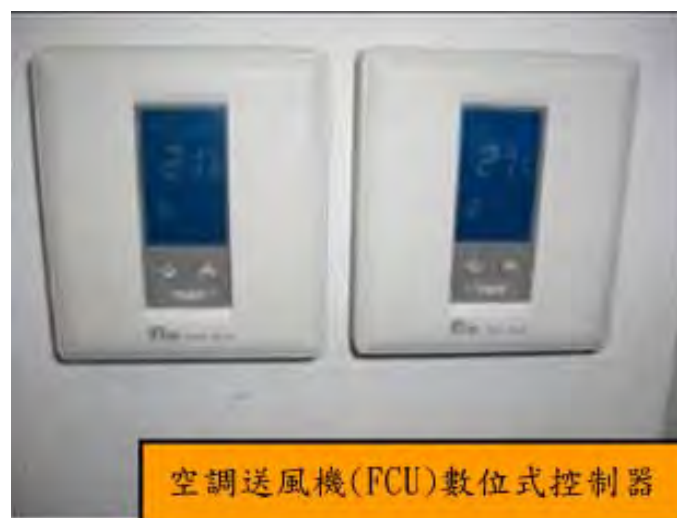
圖 5.2-4 總統府空調系統風機數位式控制器
