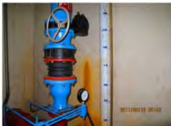
改善前儲冰槽水位融量顯示情況
