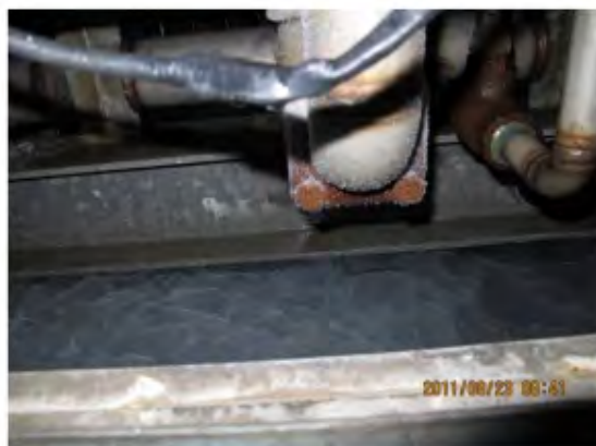
改善後儲冰槽儲冰顯示情況
