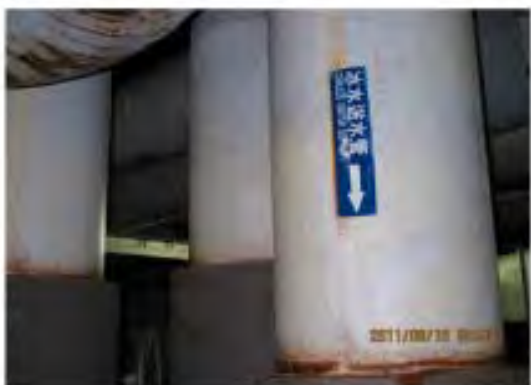
自冰水送水管外接管路，進行排水
