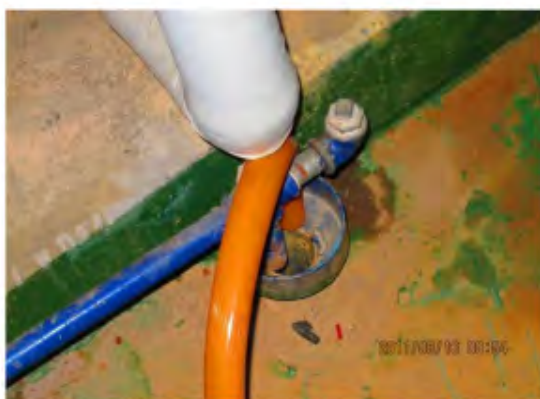
自冰水送水管外接管路，進行排水
