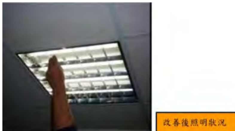
圖 5.5-7 政院衛生署朴子醫院照明改善
