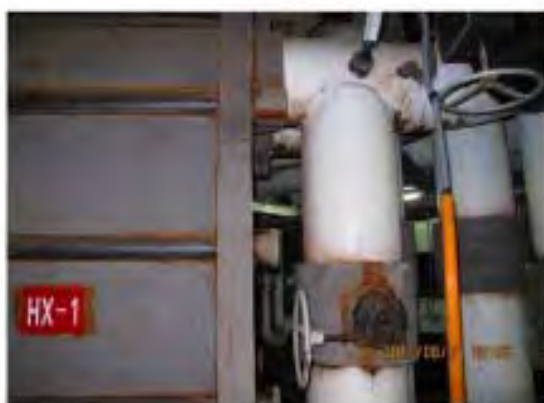
自冰水送水管外接管路，進行排水
