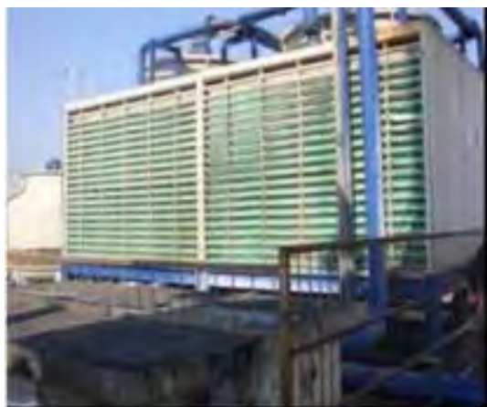
圖 5.5-5 政院衛生署朴子醫院冷卻水塔散熱片更新
