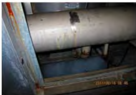
改善前儲冰槽儲冰顯示情況
