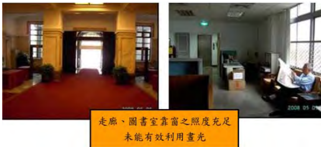
圖 5.2-6 總統府照明系統狀況
