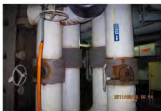
自冰水送水管外接管路，進行排水
