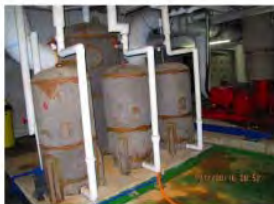
自冰水送水管外接管路，進行排水
