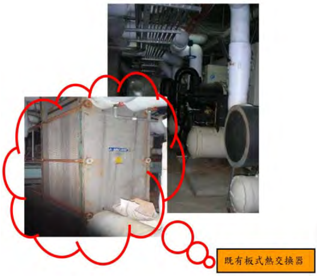
圖 5.3-4 國立台灣大學圖書館空調系統板式熱交換器
