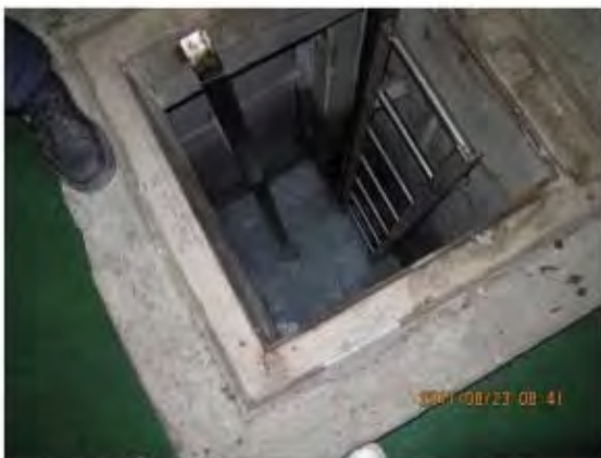
改善後儲冰槽儲冰顯示情況
