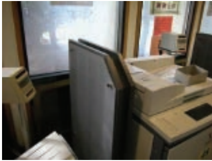
1. 影印機側裝設吸音隔板
