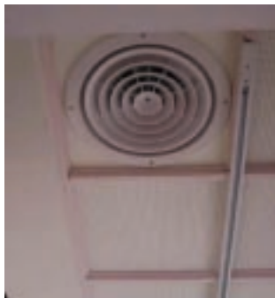
3.更換穿孔石膏板增加吸音力
