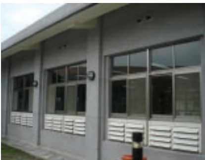
3. 窗戶下部設置水平導風板
