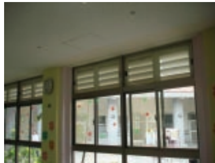
2. 窗戶上部設置水平導風板
