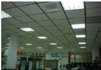
3. 受潮損壞天花板修繕更換
