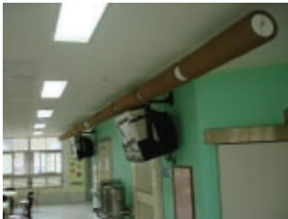
1. 新增之天花板及吸音筒
