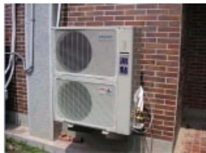
4. 增設分離式空調箱及抽風機
