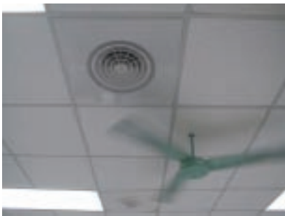
3. 天花板空調出風口更新
