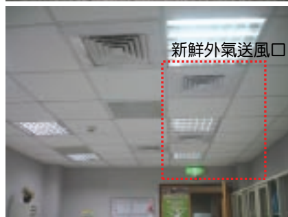
圖 4-9 二氧化碳自動感應器及新鮮外氣送風口
