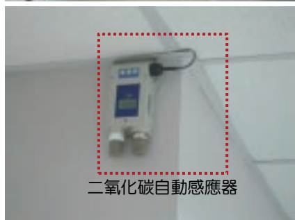
圖 4-9 二氧化碳自動感應器及新鮮外氣送風口
