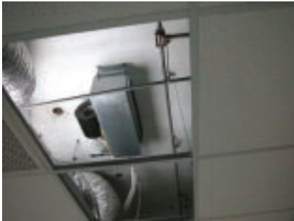
1. 溫熱環境改善後現況
