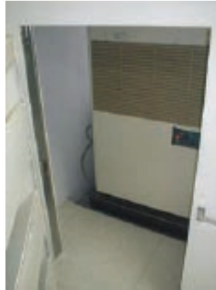
2. 增設空調箱外部隔音櫃
