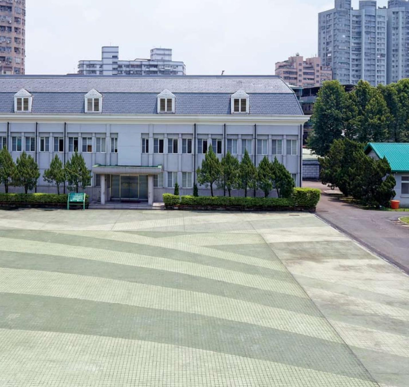
▲圖1：廣場採用透水管透水鋪面，可以負荷重車。
