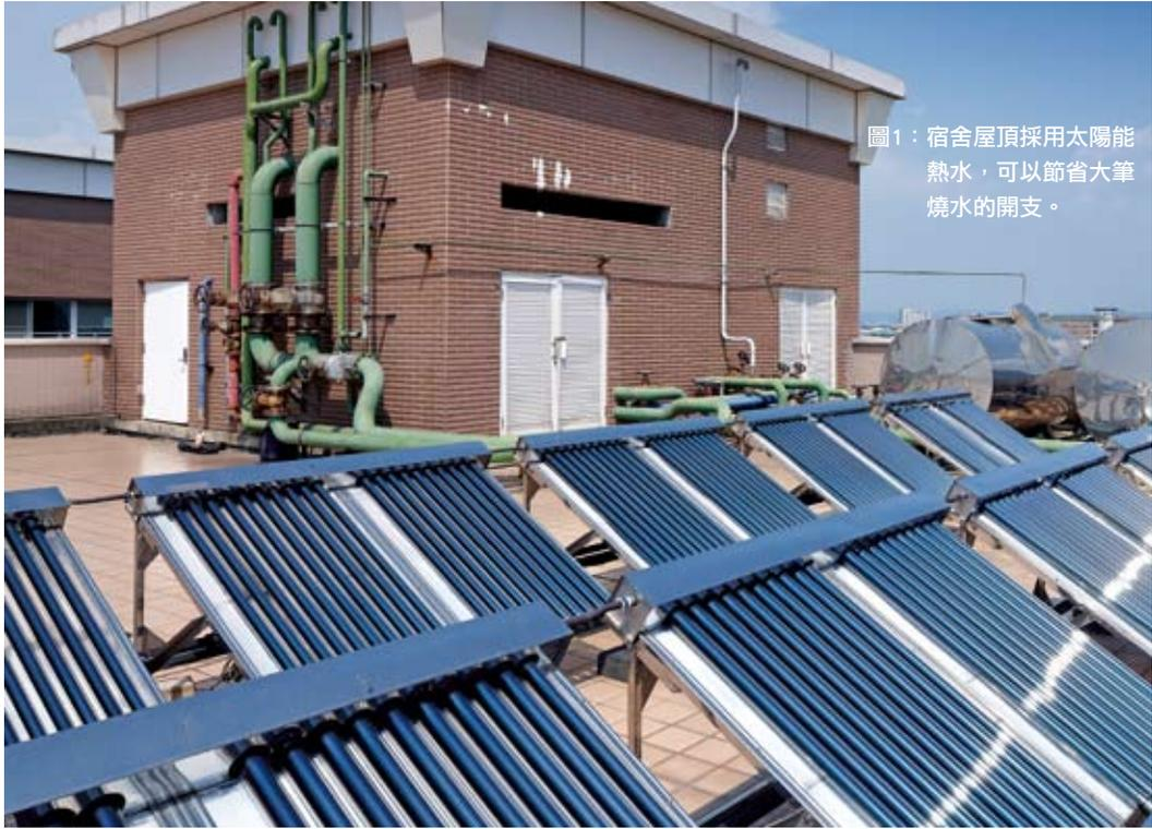
圖1：宿舍屋頂採用太陽能熱水，可以節省大筆燒水的開支。
