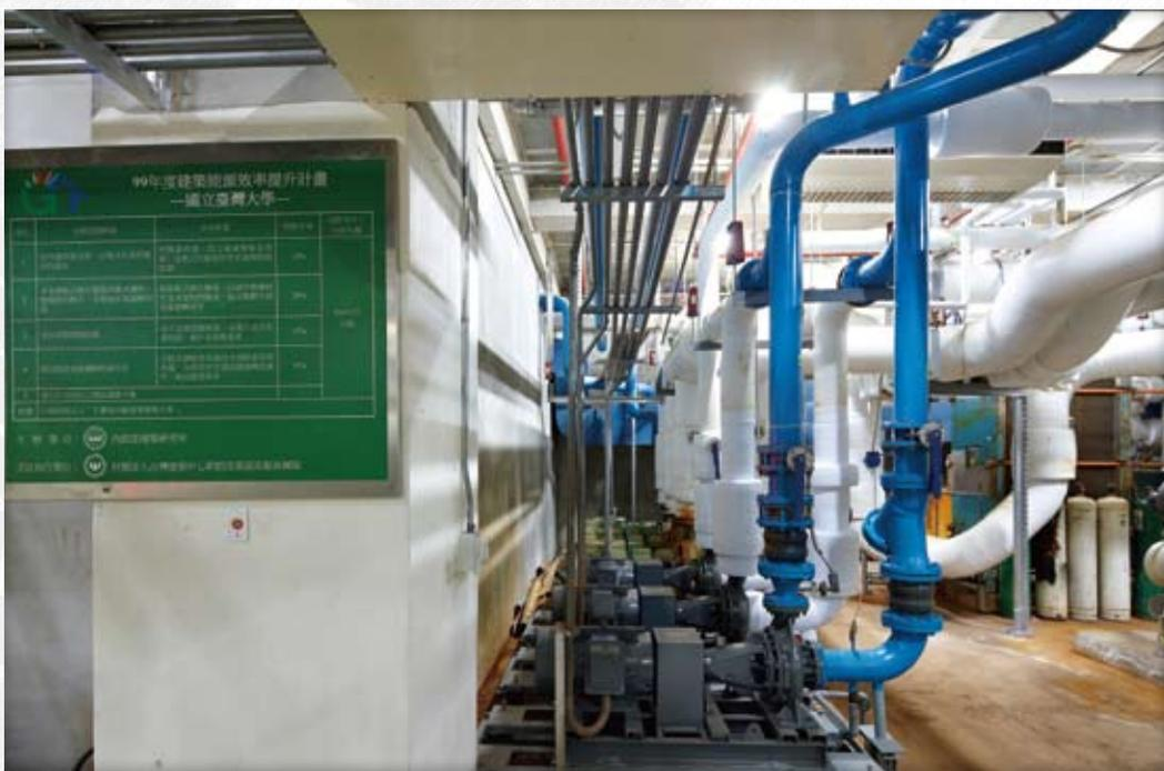
▲圖1：控制改變冰水的流量，就可以減少無謂的耗電。
