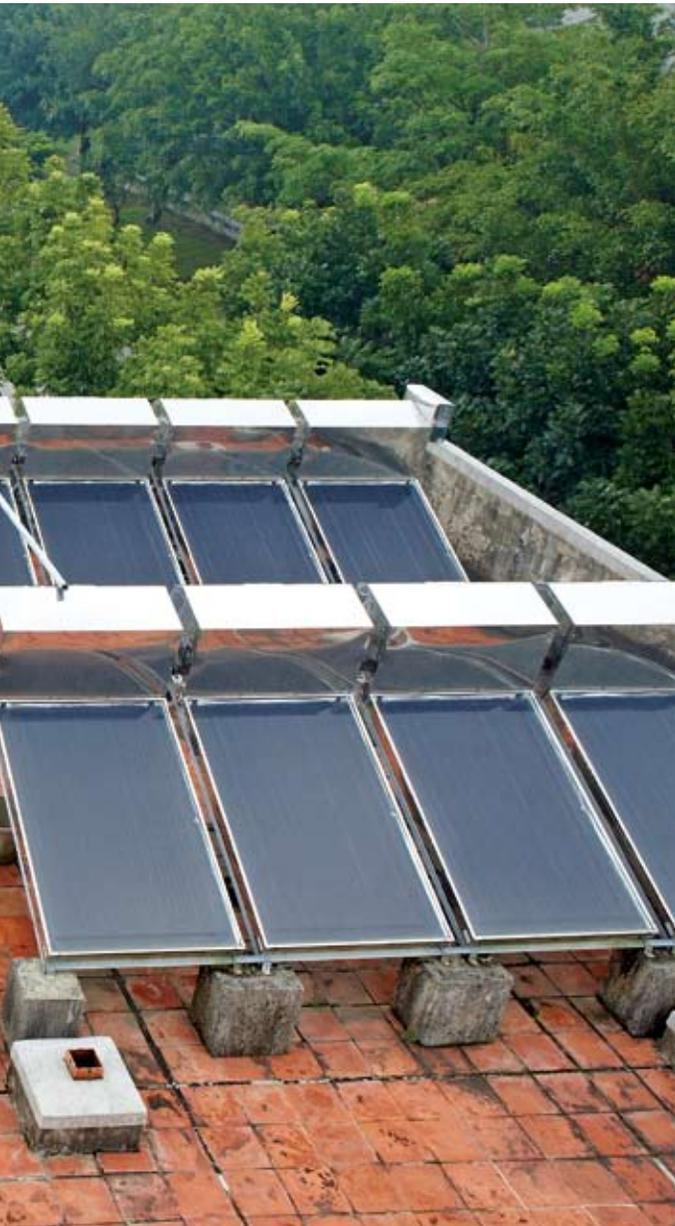
雲科大的各種綠改善中，最具特色也最具效益的，就是太陽能熱水技術的運用。在學生宿舍的屋頂架設高效率太陽能熱水系統，再以原有的鍋爐系統搭配輔助，每年可節省約53%的瓦斯費用，約47萬元。另外更出租其他校舍屋頂的閒置空間供廠商合作建置太陽能發電系統，增加租金及回饋收入等，每年約增加900多萬元收入，完全善用了天然資源的優勢讓陽光變黃金。
