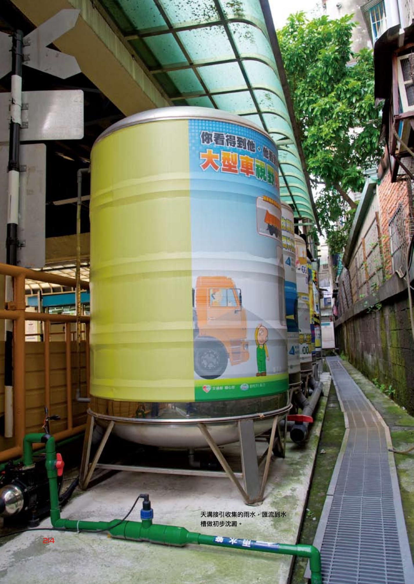
天溝接引收集的雨水，匯流到水槽做初步沈澱。
