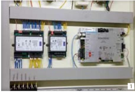
原本的固定風量系統，無法依照室內的負載，進行彈性的調節。而在風管的末端裝設壓力感測器，就能控制變頻器，調整風量。另裝設溫度感測器，則能調整風門開口角度，調節風量。
