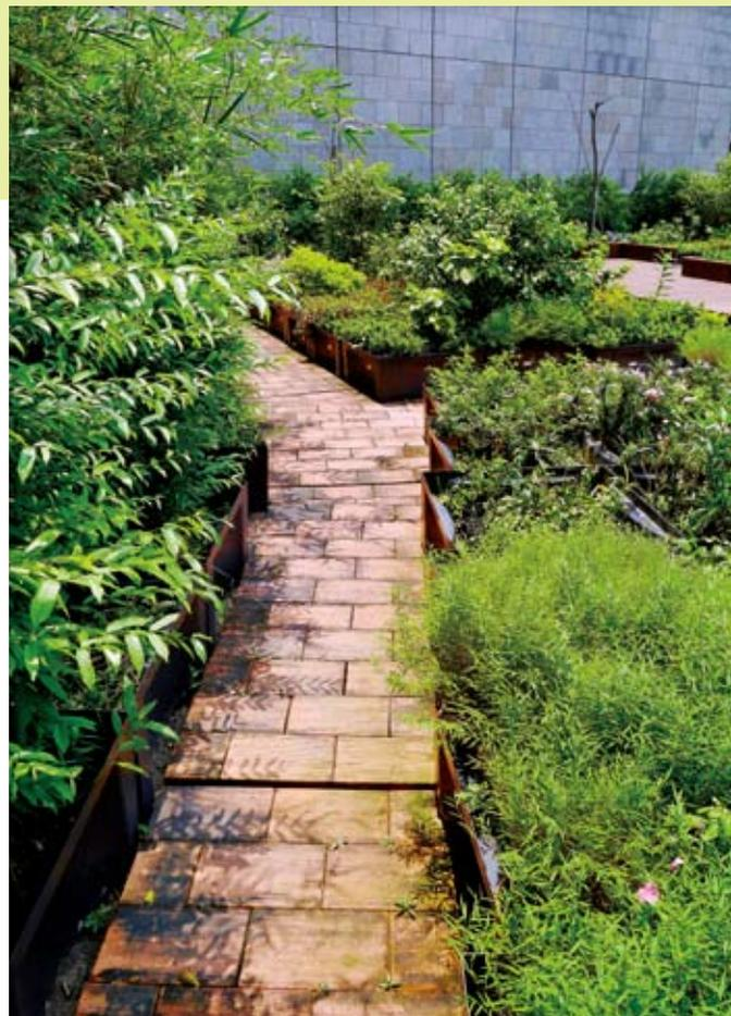
科工館的植栽槽很特別高約35公分，在離地大約3公分地方開了一排小洞，讓多餘的水排出。為了維持土壤通風、避免植物根部腐爛，植栽槽底部鋪有一層陶粒，是利用水庫的淤泥燒製而成，也是廢棄物再利用的最佳示範，這種陶粒裡面有很多小孔洞，使它具有質量輕、含水性高的特色，是現在很常用的庭園小物。
