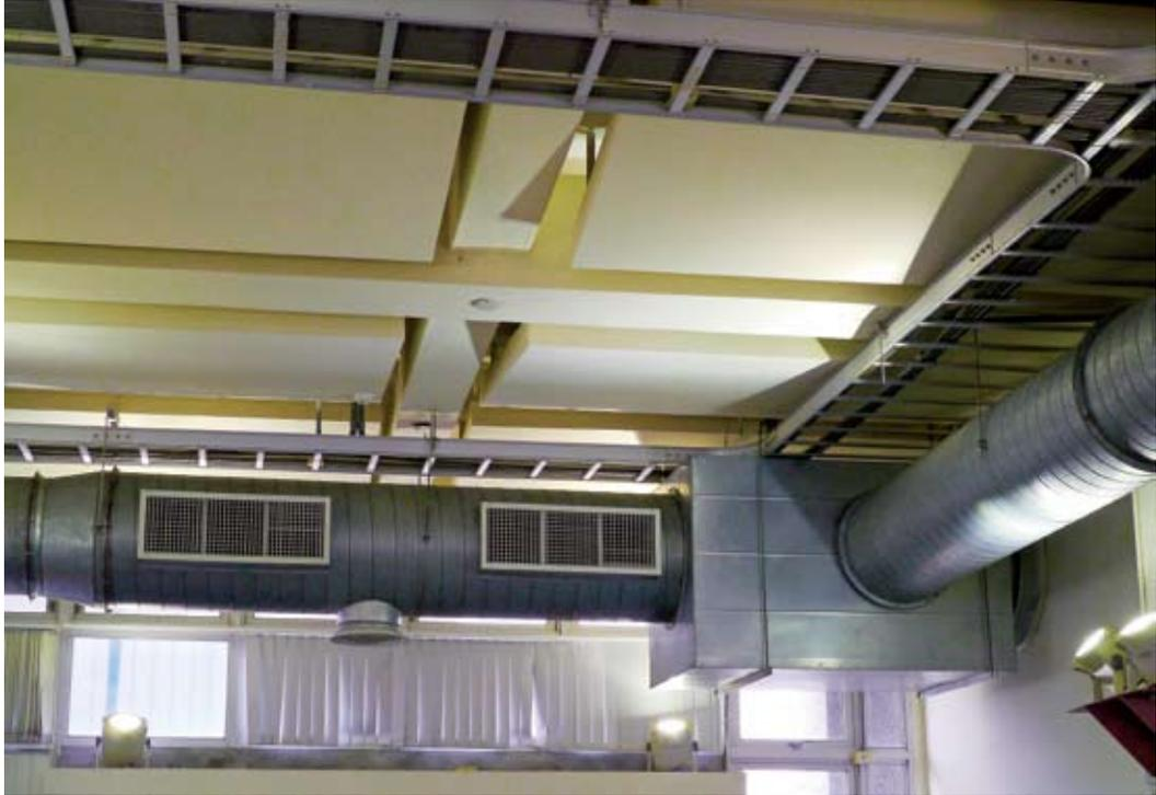
▲圖1：園區的空調通風管以明管設計方式製作。
