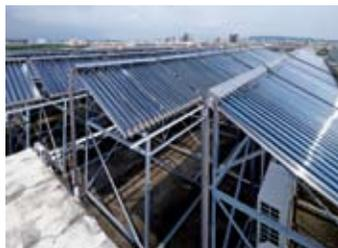
◀ 圖2~3：太陽能熱泵系統可以更有效地從太陽能熱水中收集熱能。
