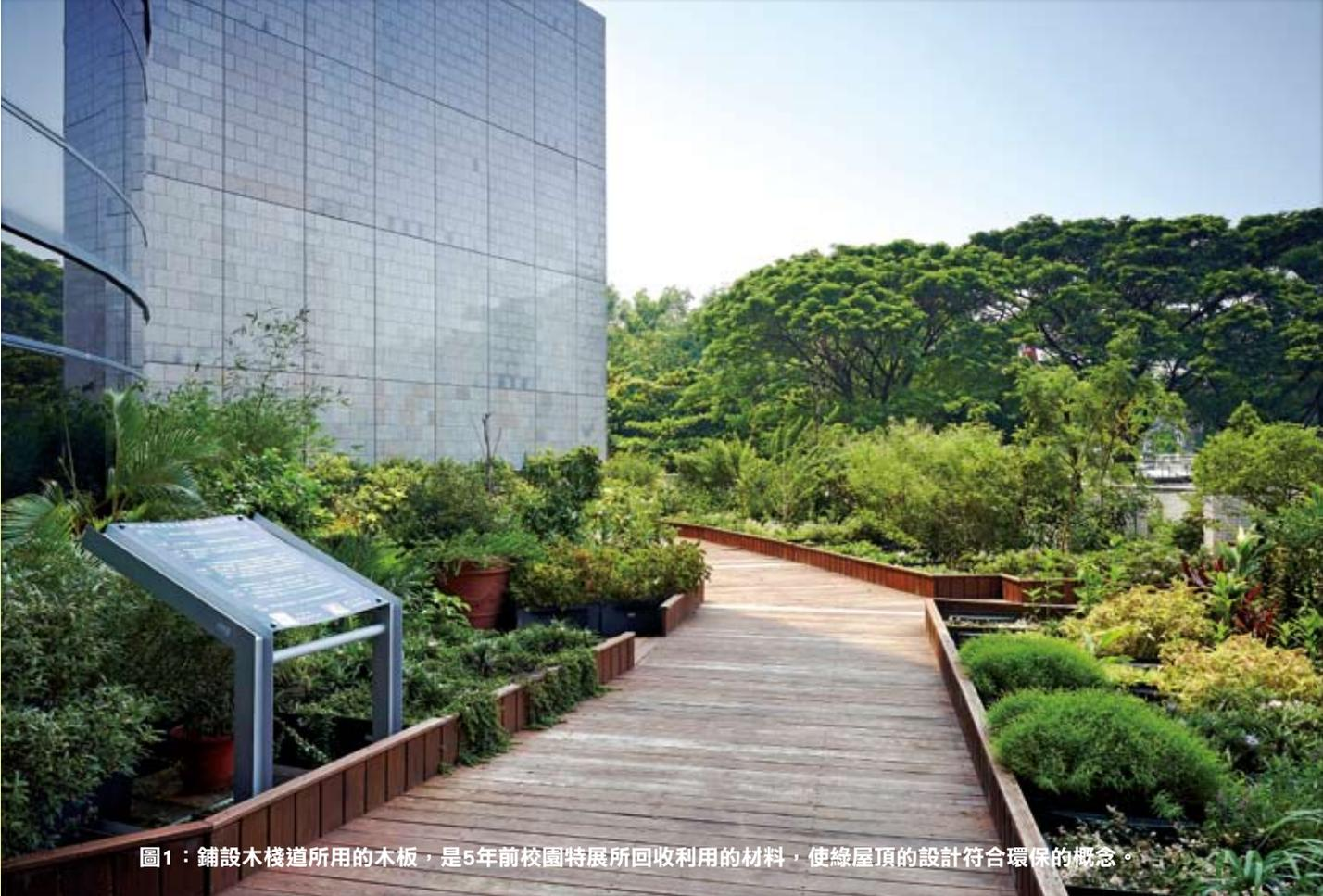
圖1：鋪設木棧道所用的木板，是5年前校園特展所回收利用的材料，使綠屋頂的設計符合環保的概念。
