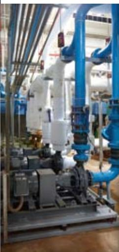
**國**立臺灣大學圖書館並非老舊建築，但是空調系統已經不是最新最有效率的，在改善系統的同時，也以新的BEMS汰換掉舊有的BEMS，有效管控空調設備的運轉，並引入TAB，更進一步調校提高效率。其它機電不算，光BEMS系統就為國立臺灣大學圖書館每年省下66萬度的耗電，相當於每一平方公尺就省下將近2度，（下圖）左側舊有監控系統邏輯控制，已經不符合現今空調節能控制，右側為新置的BEMS。
