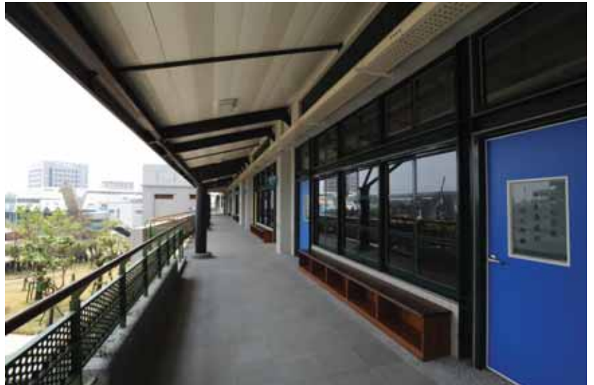
圖5.71 教室外的通廊皆以冲孔鋁板欄杆和深遮陽設計，突顯亞熱帶建築設計的美感。
