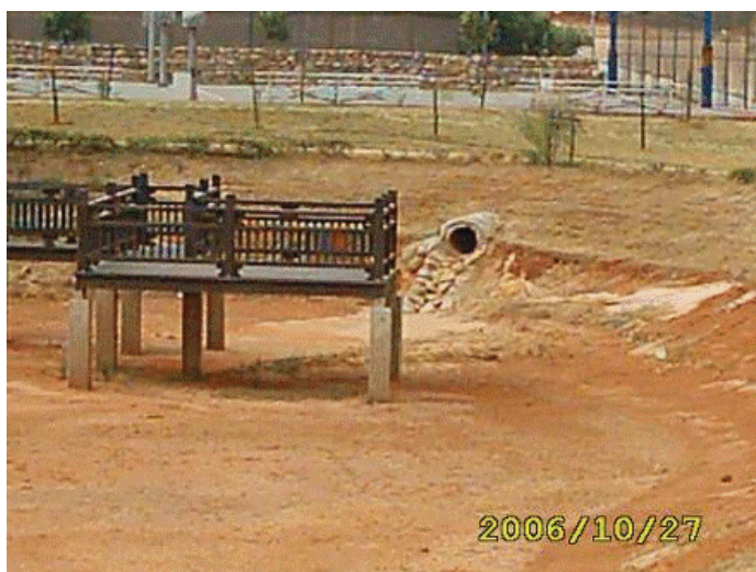
圖4.49 水源不足情況下造成池底乾枯現象，已失去生態池功能且不具景觀效益(改善前)
