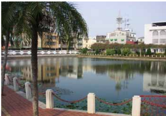
圖4.5 水深且無良好護欄易發生摔落水塘之意外(改善前)
