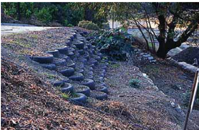
圖3.28 廢輪胎作成的擋土邊坡
