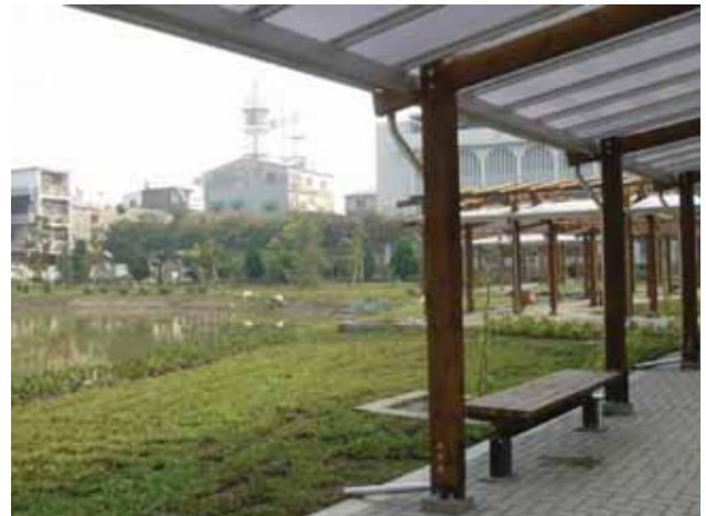
圖4.4 可供休憩的木廊道與透水磚鋪面(改善後)
