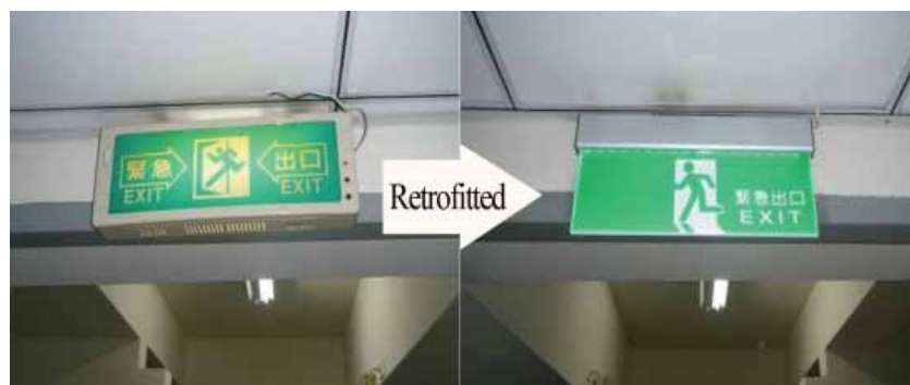
圖4.53 以更換螢光燈管之出口指示燈為LED指示燈之照明改善手法
