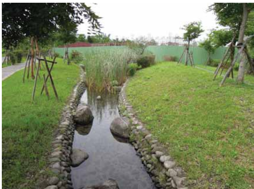
圖5.25, 5.26 基地南面以溪流水岸作為邊界，水岸以卵石護岸可作為小生物棲地，緩坡及豐富的水生植物營造生態水域。
