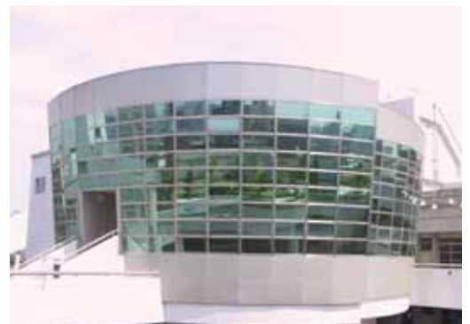
圖1.7 某國中行政大樓採玻璃帷幕牆設計而嚴重浪費空調能源
