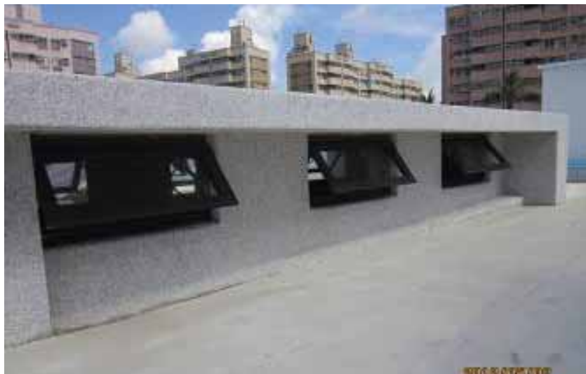
圖3.19 屋頂採用透氣孔，達到良好通風與隔熱效果
