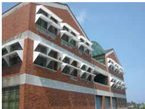
圖4.28 南向立面加裝遮陽的效果十分良好(改善後)
