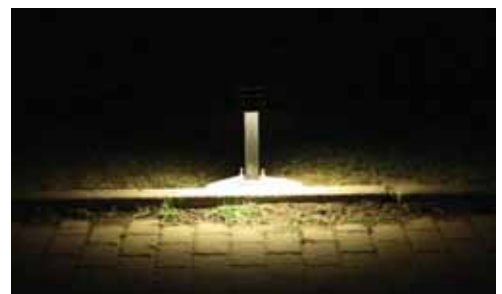
圖4.40 23W 3U省電燈步道矮燈高遮光角燈具，光線不逸散。(改善後)
