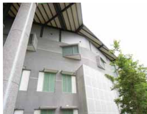
圖5.27 鋼浪板長雨庇，水平及格子遮陽，百葉窗及沖孔板皮層等豐富的遮陽形式構成凱旋國中校舍建築優美的立面韻律。
