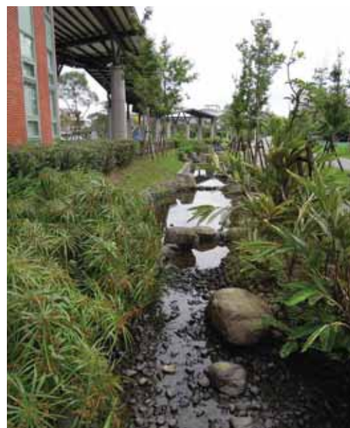
圖5.25, 5.26 基地南面以溪流水岸作為邊界，水岸以卵石護岸可作為小生物棲地，緩坡及豐富的水生植物營造生態水域。
