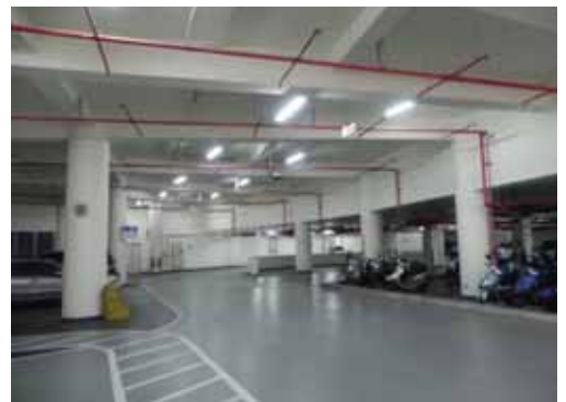
圖3.49 一般地下室無適當開口引入陽光及空氣，即使是白天亦須開燈
