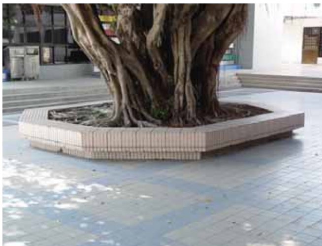
圖4.15 體育館前廣場不透水化以及水泥化的花台扼殺老樹生機(改善前)
