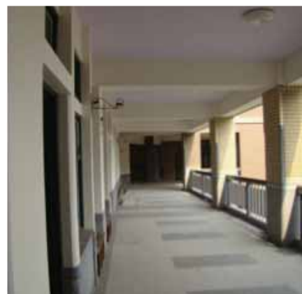
圖5.14 單邊走廊及透空欄杆有助教室通風
