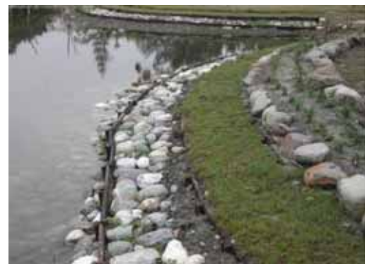
圖4.12 農經科-改善後植生工法提供多孔隙的空間(改善後)
