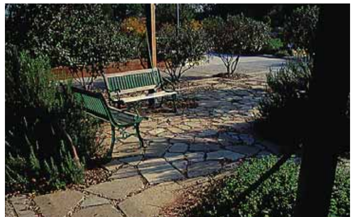
圖3.29 廢棄混凝土塊作成的景觀鋪面
