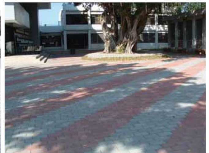
圖4.16 解除老樹的束縛，以乾砌砂石塊作收邊處理(改善後)
