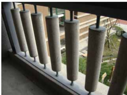
圖5.13 回收營建廢棄物再製成的欄杆
