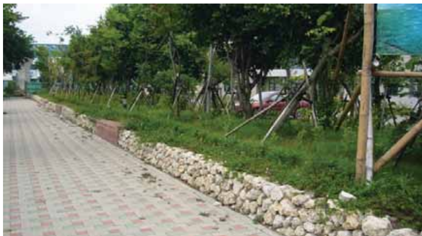
圖5.65 由咕啞石疊砌而成的生態邊坡
