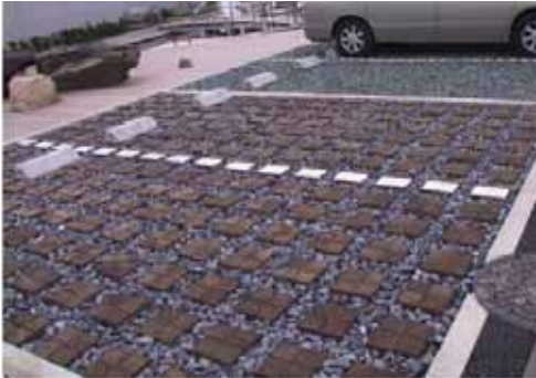
圖3.44 利用木塊與碎石設計的透水停車場
