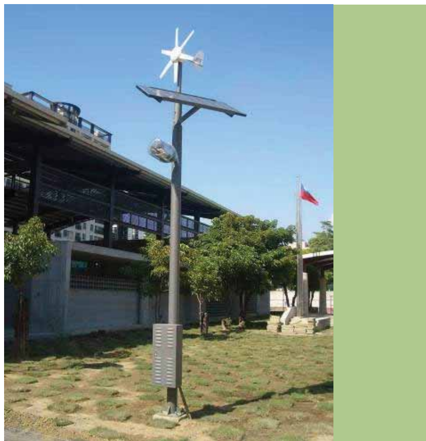
圖3.67 臺南市忠孝國中結合太陽能與風力發電的庭園燈，僅設立一盞供夜間輔助照明，作為教學示範
