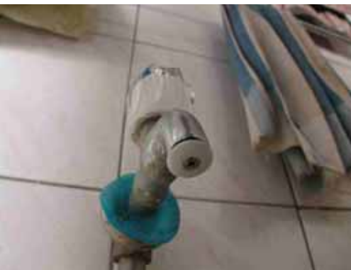
圖4.48 加裝省水器具後的細部(改善後)
