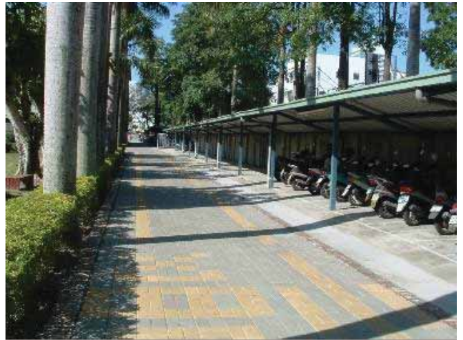
圖4.14 連接停車場的車道改造成透水鋪面，兩側排水並以盲溝處理(改善後)
