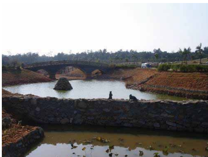
圖4.50 改善後的生態池已開始進行提供充足再生水源及雨水蓄水來營造生態環境(改善後)
