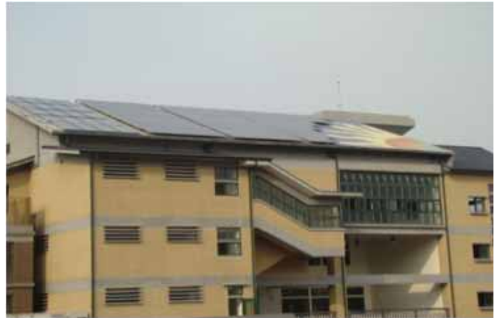
圖5.10 屋頂太陽能光電板及熱水系統
