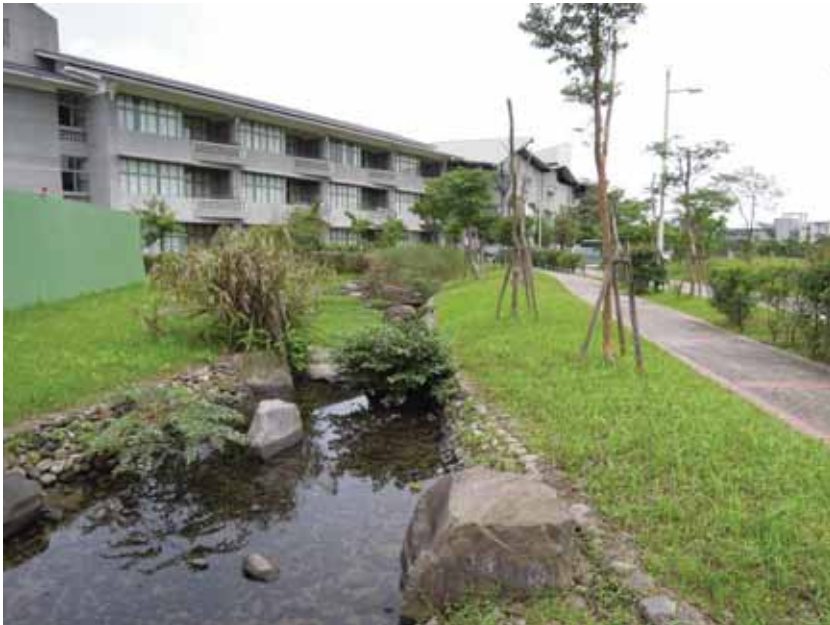
圖3.68 宜蘭市凱旋國中溪流水岸 以卵石堤岸取代水人工池岸水泥，提供小生物足夠的間隙，池邊護岸豐富的水生與陸生植物，更提供了豐富的生物棲地與珍貴的自然資源。
