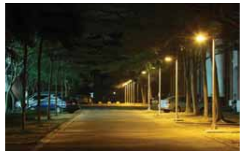
圖4.39 70W步道高燈具截光效果，光線大多集中照射於地面。(改善後)
