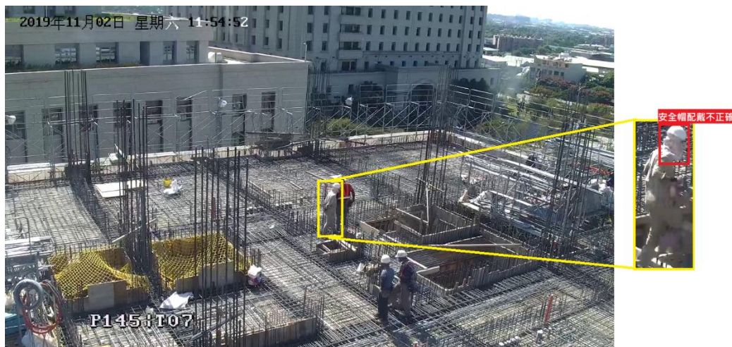
圖 2.18 施工人員安全裝備自動檢查情境
