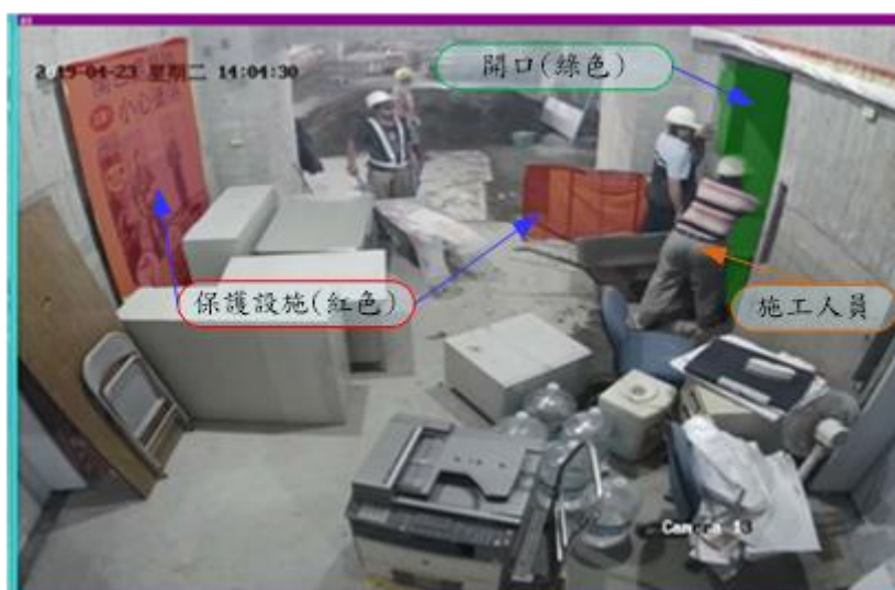
圖 2.19 建築工程施工中之電梯間影像語意分割辨識情境
