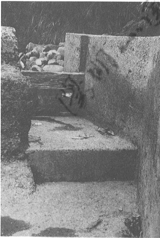
15. 新店溪桂山魚梯的入水口水位調整板結構。
