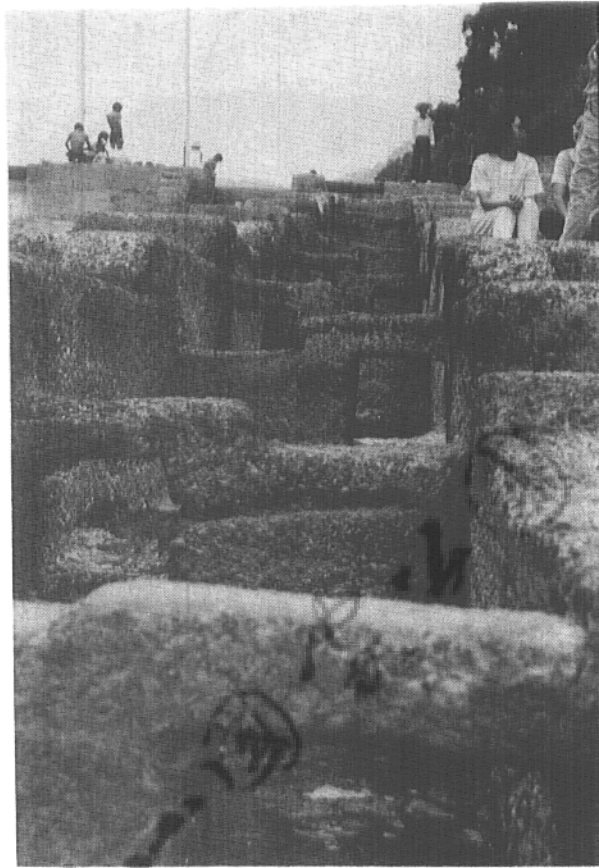
16. 新店桂山魚道的隔壁結構， 本魚道是台灣最早興建的魚道
