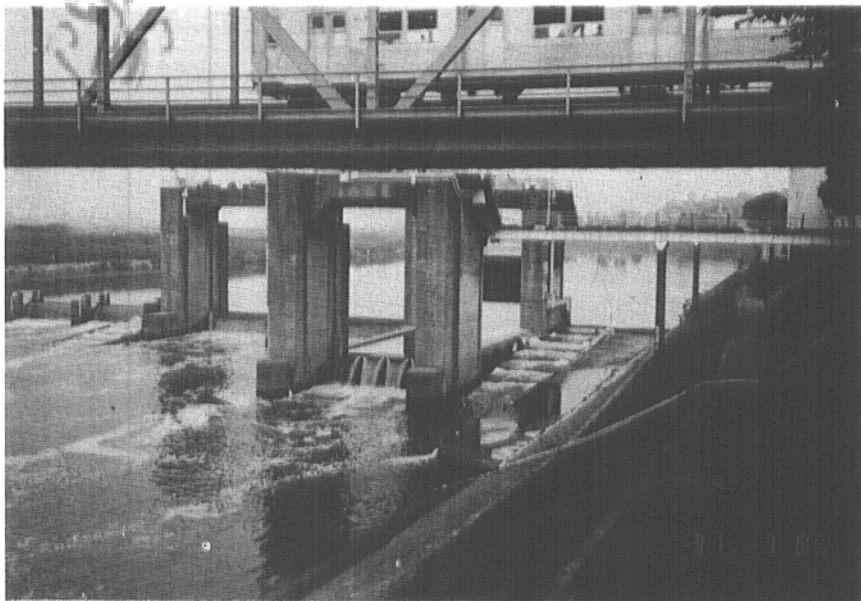
17. 東京多摩川防潮堰的魚道，原設於中央的魚道 效果不佳，後來在其右側設一新的魚道效果較好。
