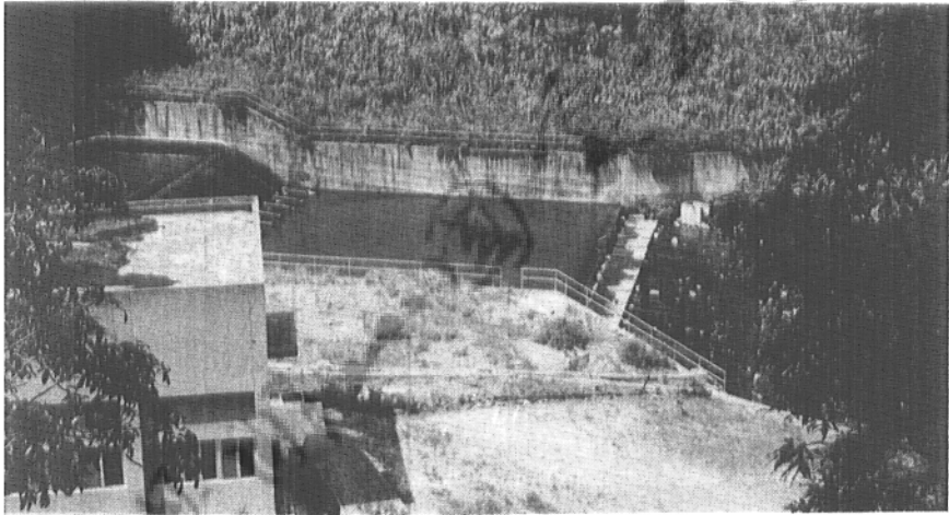
5. 鹿角坑溪取水堰和第一加壓站。
