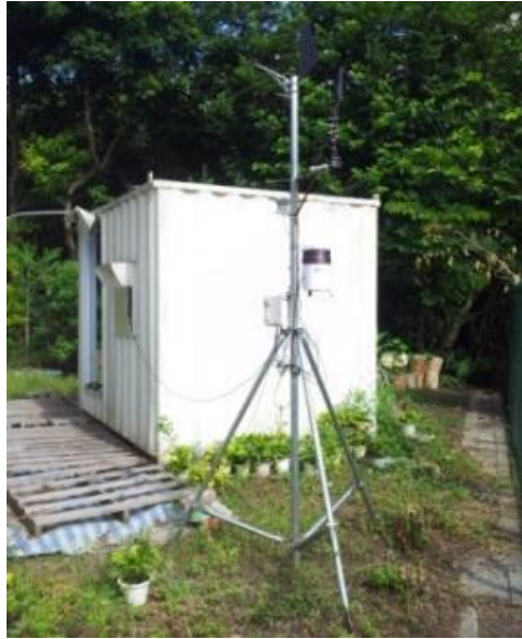
圖 1-3 臺大生物環境系統工程系實驗屋 (資料來源：余文元 2013)
