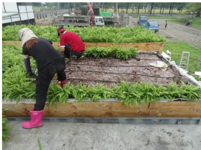
圖 2-9 屋頂綠化滴灌系統施工過程 (資料來源：本研究拍攝)
