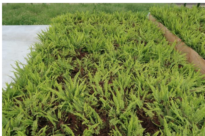
圖 2-11 薄層型(15cm 覆土)屋頂綠化完工照片 (資料來源：本研究拍攝)
