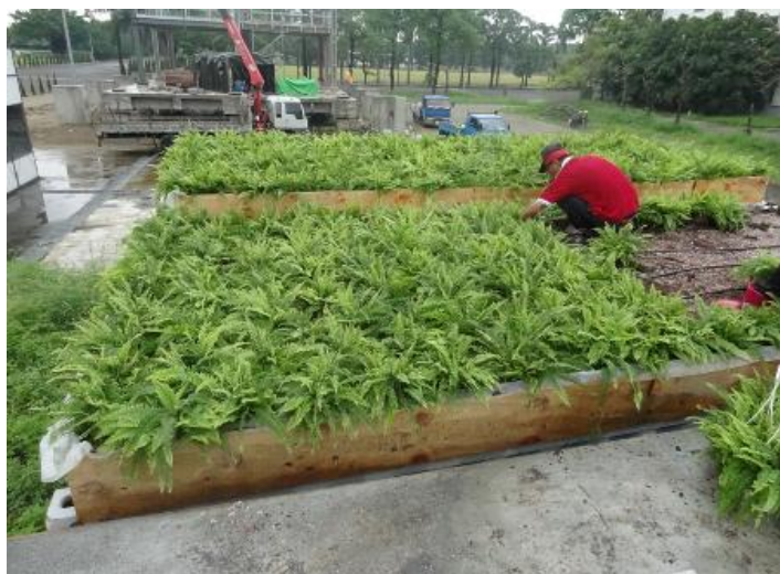
圖 2-10 屋頂綠化植栽種植施工過程 (資料來源：本研究拍攝)
