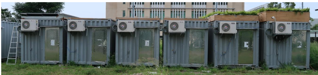
圖 2-6 六組實驗屋頂完工情形
