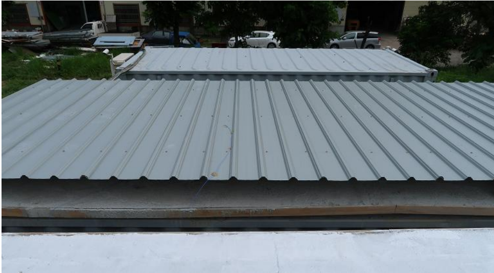
圖 2-15 雙層通風屋頂完工照片
