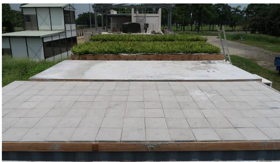
圖 2-7 屋頂隔熱完工情形
