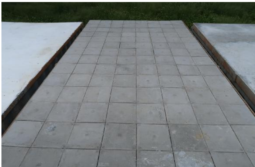
圖 2-21 五腳磚屋頂完工照片 (資料來源：本研究拍攝)
