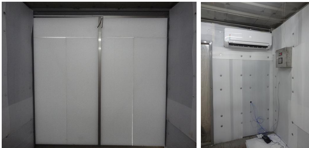
圖 2-5 實驗屋改裝情形
