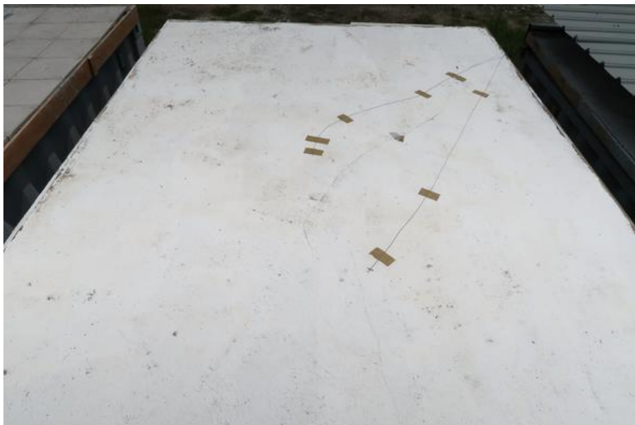
圖 2-17 冷屋頂完工照片
