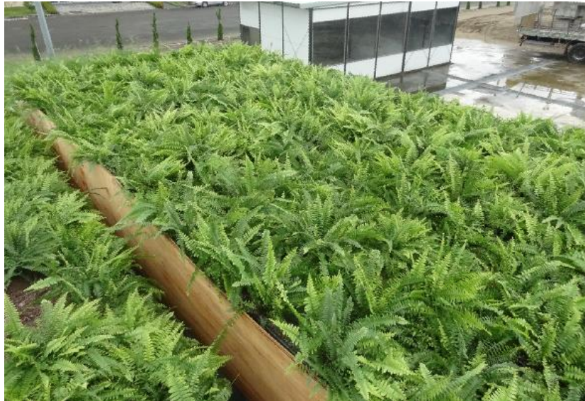
圖 2-13 密集型屋頂(40cm 覆土)完工照片 (資料來源：本研究拍攝)
