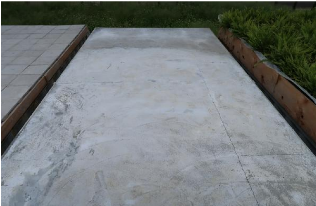
圖 2-19 PS 板隔熱屋頂完工照片
