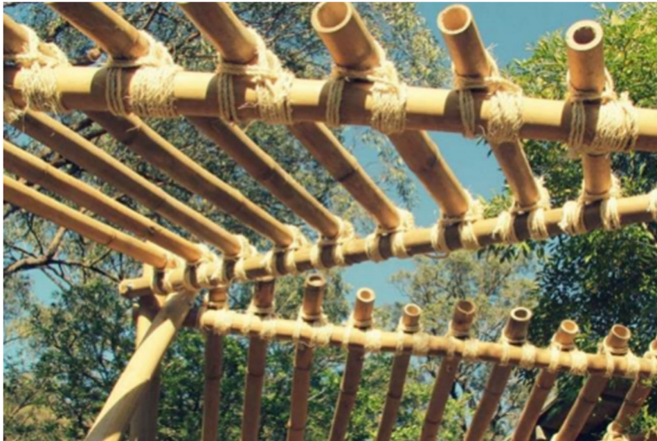
圖 7.2 以麻繩綁紮接合之竹構造[7]
