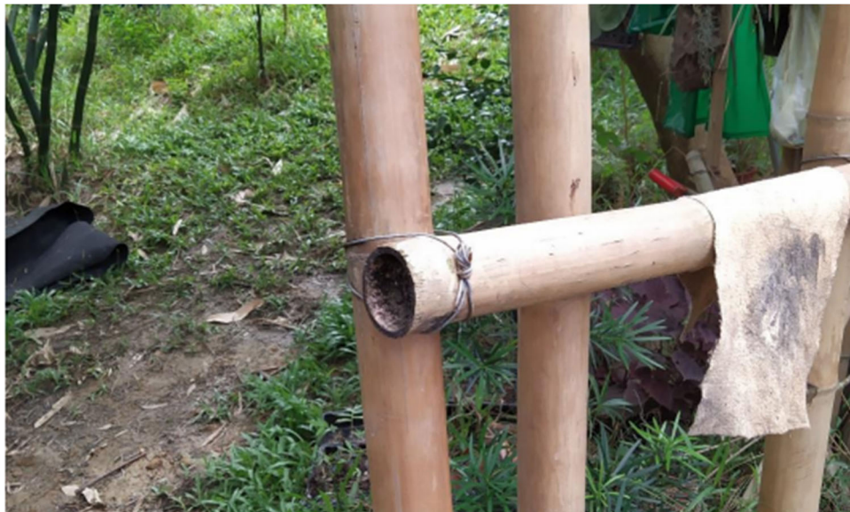
圖 7.10 以鐵線綁紮之正交橫接[5]
