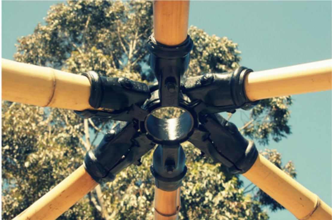
圖 7.4 連接外包式夾具之金屬多向接頭[7]
