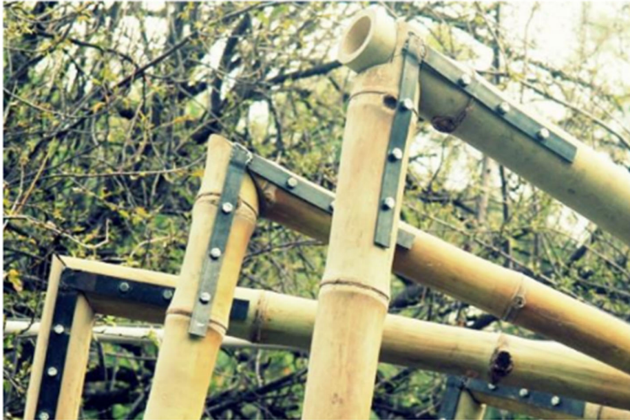
圖 7.12 以金屬側板接合的共平面接合[7]
