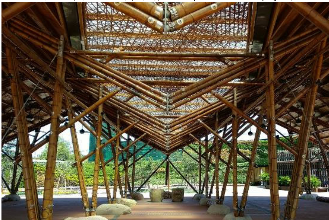
圖 5.28 內部接合設計 (取自 https://architdz.com/project/ )
