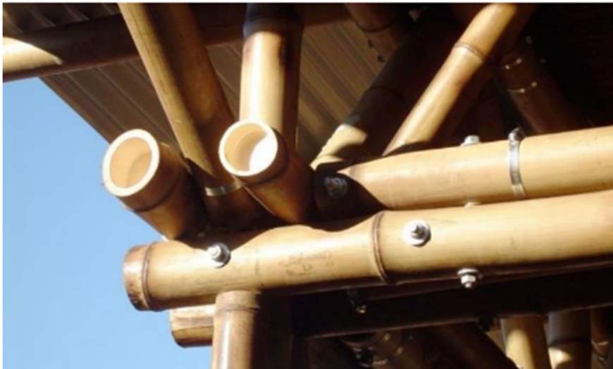
圖 7.1 以螺栓接合之竹構造[7]
