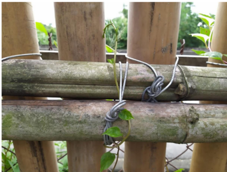
圖 7.3 以鐵線綁紮接合之竹構造[5]
