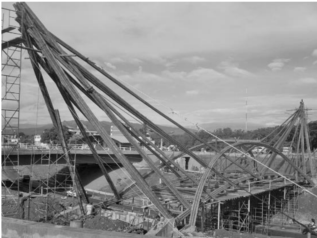
圖 5.23 Cucutá Bridge, Jörg Stamm 之竹結構系統 (Carmioli-Umaña 2016)
