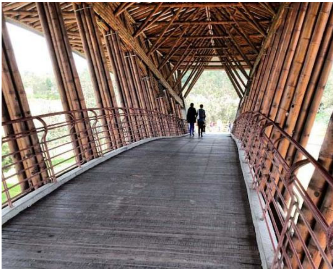
圖 5.22 Guadua Jenny Garzón Bridge 之內部結構與橋面 (取自 https://arquitecturayempresa.es/noticia/un-cambio-pionero-sostenible-para-el-urbanismo-capitalino-puente-jenny-garzon )
