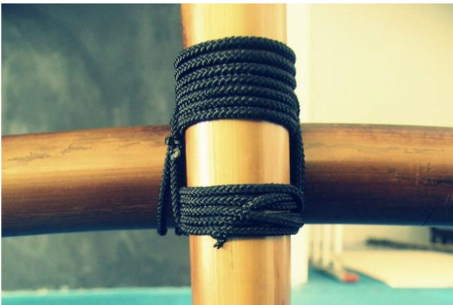
圖 7.13 以尼龍繩綁紮接合之不共平面接合[7]
