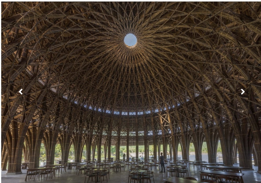
圖 5.7 Vedana 餐廳之屋棚構造 (取自 https://vtnarchitects.net/en )
