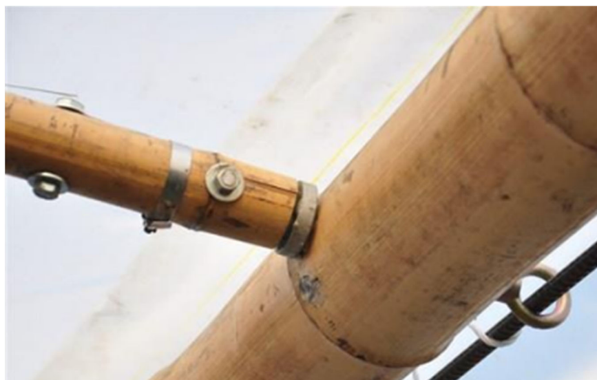
圖 7.7 以鐵件圍束之竹構接合[5]
