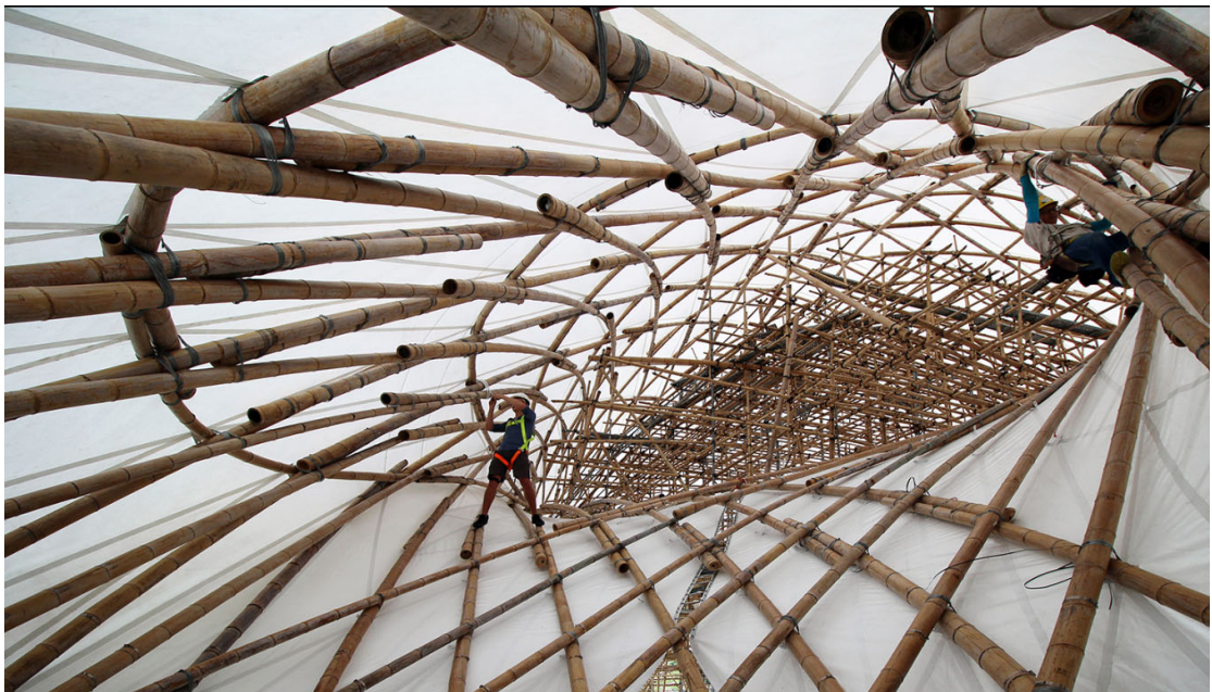
圖 5.20 施工中的零碳竹棚(取自 https://www.archdaily.com/800173 )
