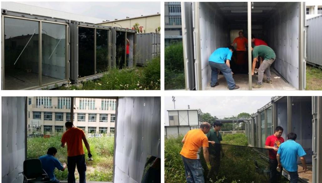
圖3-2 實驗玻璃的換裝
