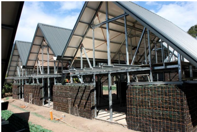
圖 1.5 採以工代賑完成的輕鋼構造八八風災重建永久屋，建議在 CO 2 減量、廢棄物減量等指標上可被認定為滿分
