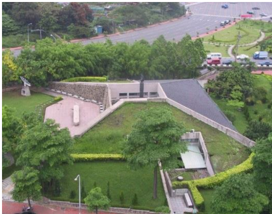
圖 1.4 嘉義市二二八紀念館覆土建築與雙層牆通風除濕設計，建議在生物多樣性、日常節能兩指標上可各加 2 分
