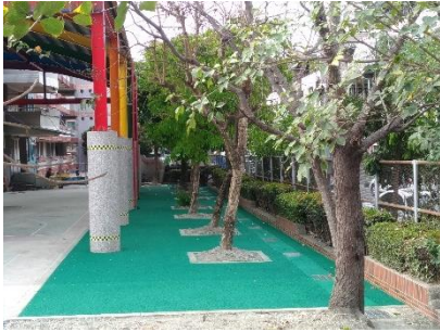
圖 7-7 現場整體澆置之剛性透水鋪面
