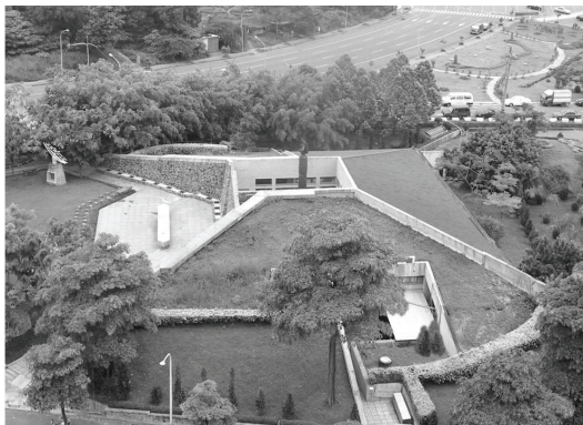
圖1.4 嘉義市二二八紀念館覆土建築與雙層牆通風除濕設計，建議在生物多樣性、日常節能兩指標上可各加2分
