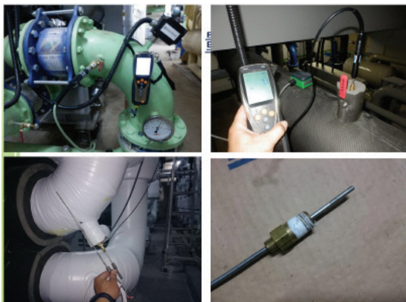
附圖3.2 系統儀表比對查核使用測試頭安裝方式
