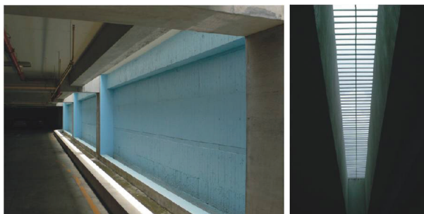
【地下室採光通風天溝設計示意圖】
