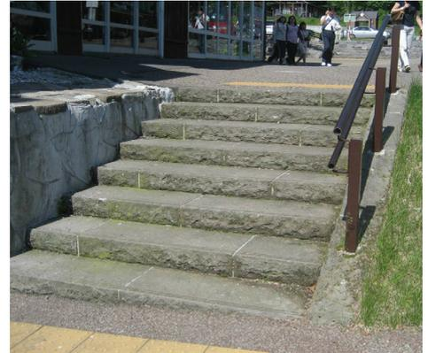
圖3-3.4 斜坡、階梯高差超過80cm應設置扶手
