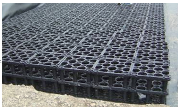
圖2-3.11地下礫石層與組合式蓄水框架的地下貯集滲透工法
