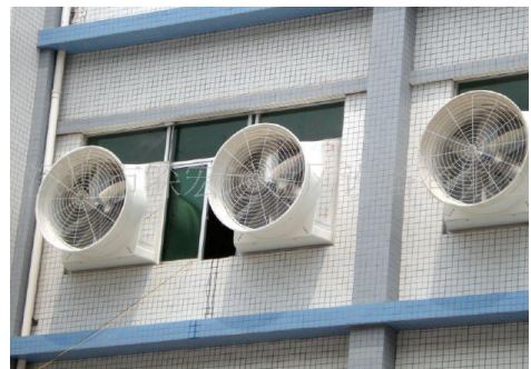
圖2-4.2 負壓風扇系統示意圖
