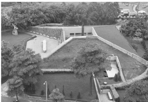
圖1.4 嘉義市二二八紀念館覆土建築與雙層牆通風除濕設計，建議在生物多樣性、日常節能兩指標上可各加2分
