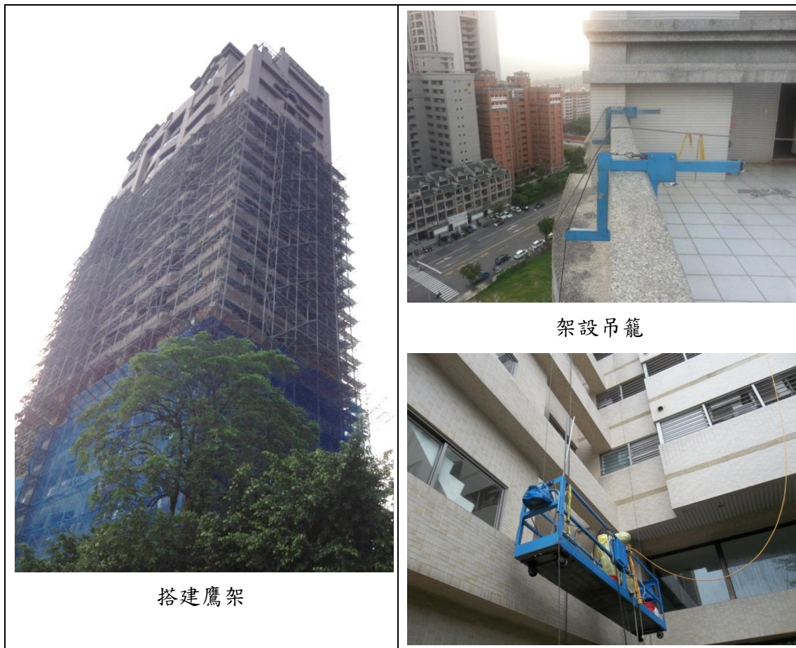
圖 3-8 搭建鷹架及架設吊籠現場照片
